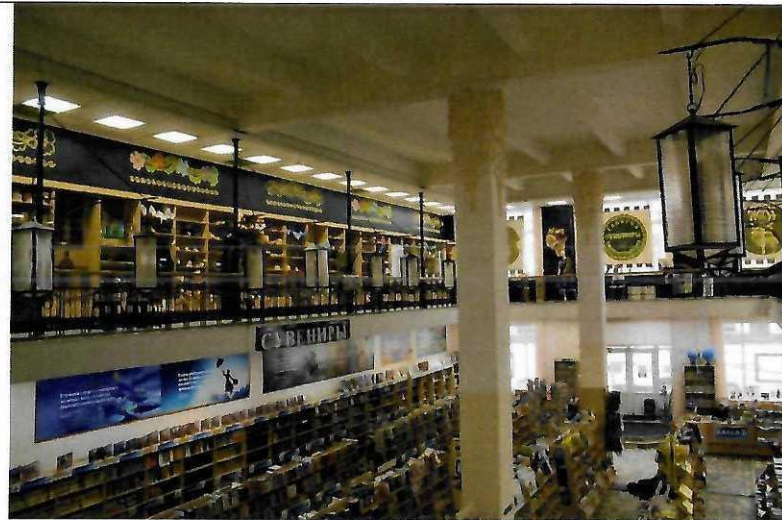
прямоугольные в плане центральные колонны
