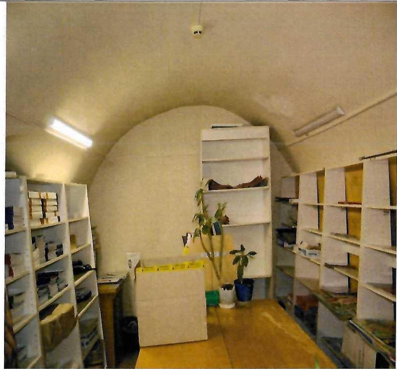
цилиндрический свод
