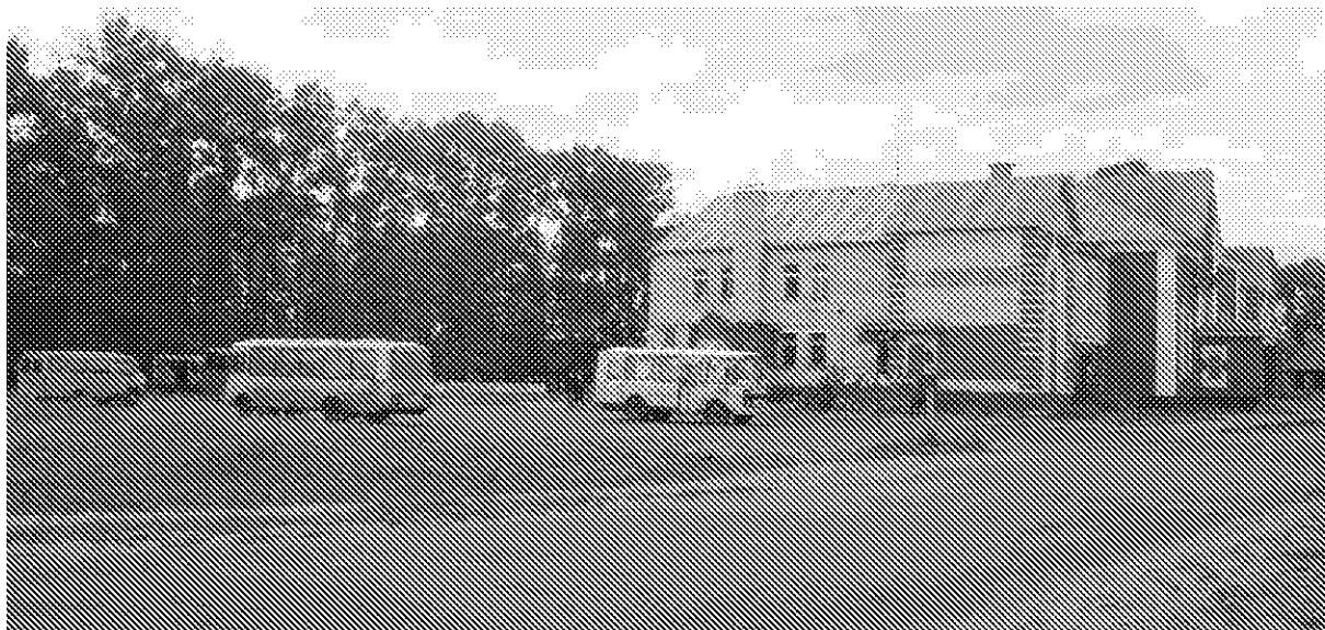
Рисунок 14. Здание и территория остановочного пункта г. Звенигово
