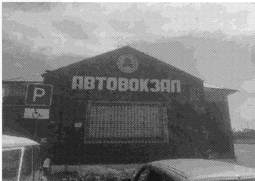
Рисунок 17. Здание автовокзала г. Козьмодемьянск
