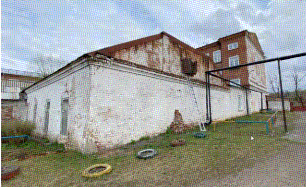
Вид на здание с западной стороны.
