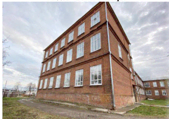
Вид на объект с востока.
