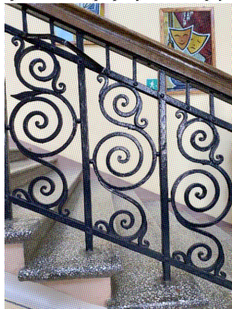
Фрагмент ограждения лестницы.
