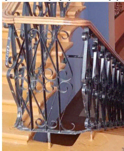
Фрагмент ограждения лестницы.
