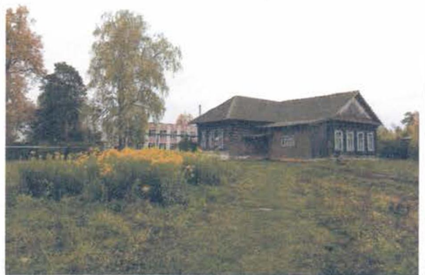
Вид на объект с севера.
