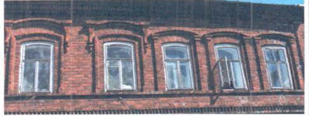
Фрагмент бокового (западного) фасада, окна 2-го этажа.
