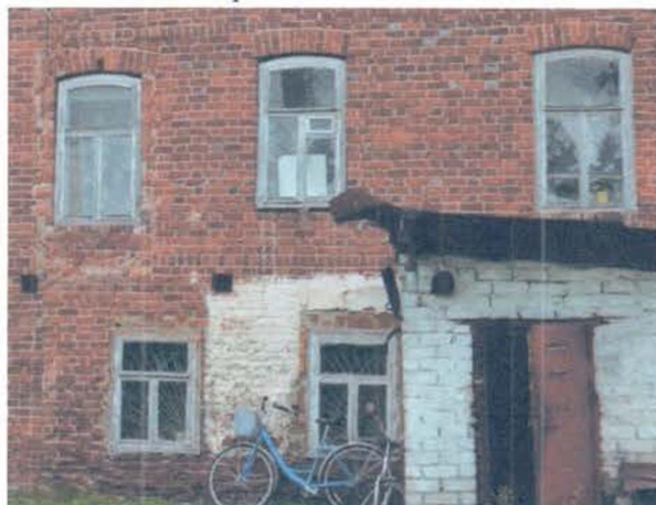
Фрагмент дворового (южного) фасада, оконные проемы 1-го и 2-го этажей.
