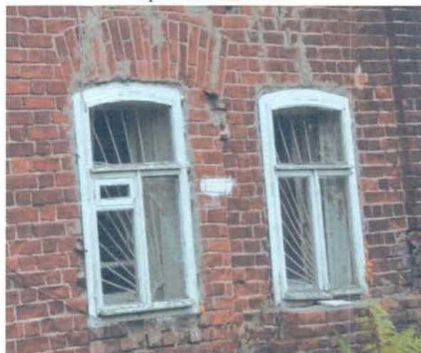
Фрагмент бокового (западного) фасада, оконные проемы 1-го этажа.
