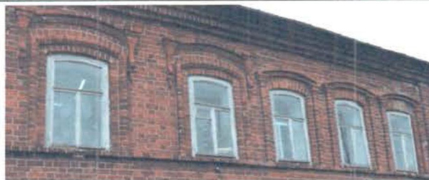
Фрагмент бокового (западного) фасада, оконные проемы 2-го этажа.
