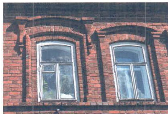
Фрагмент бокового (западного) фасада, оконные проемы 2-го этажа.
