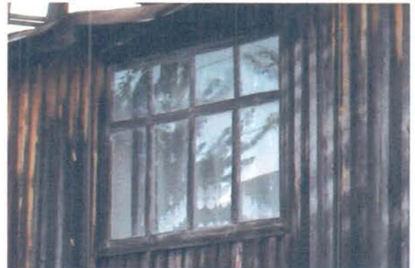
Фрагмент восточного фасада, окно пристроя.
