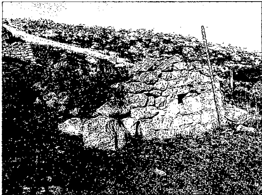
Вид с юго-запада.
