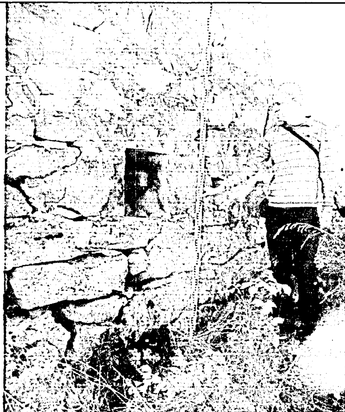
Склеп 1, лаз в северо-восточной стене.
