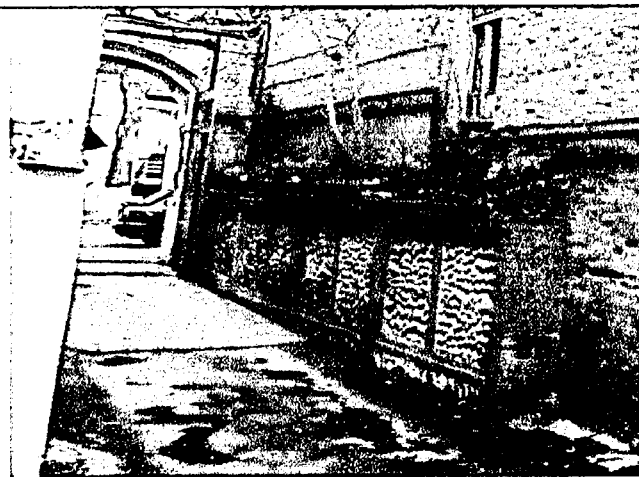
Фрагмент каменной ограды.
