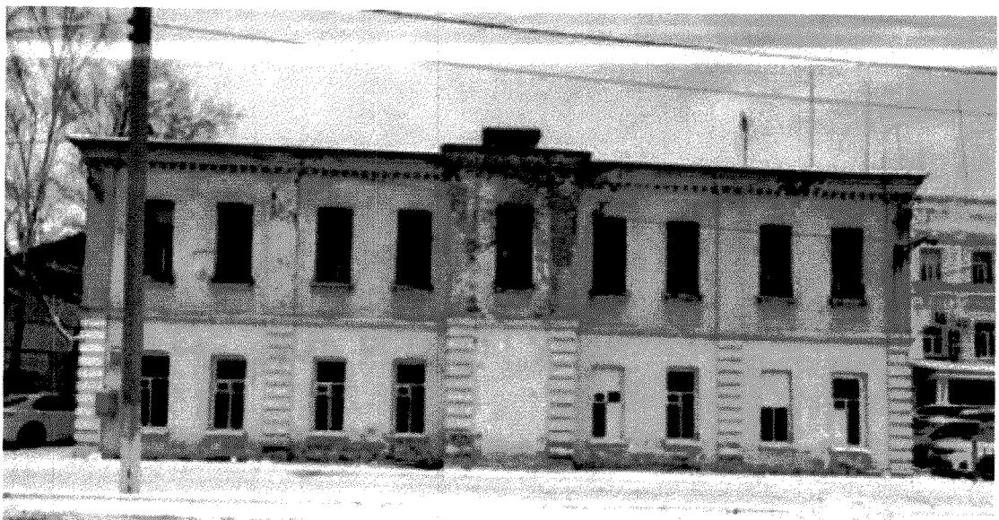
Симметричное, пятичастное композиционное решение сформировано: членением плоскости фасада здания по горизонтали центрально расположенным незначительно выступающим из плоскости фасада одноосным ризалитом, четырьмя двухосными простенками, лопатками, рустованными в уровне первого этажа; членением плоскости фасада по вертикали междуэтажным карнизом и профилированным венчающим карнизом.
