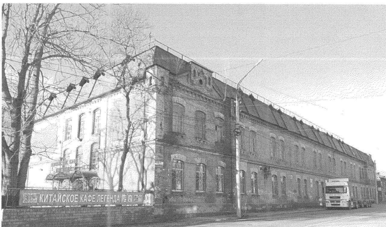
Композиционное симметричное решение сформировано членением плоскости фасада по горизонтали двумя слегка выступающими симметричными ризалитами по краям здания, которые акцентированы фронтонами, равномерным распределением оконных проемов, по вертикали – междуэтажным профилированным пояском и карнизом.
