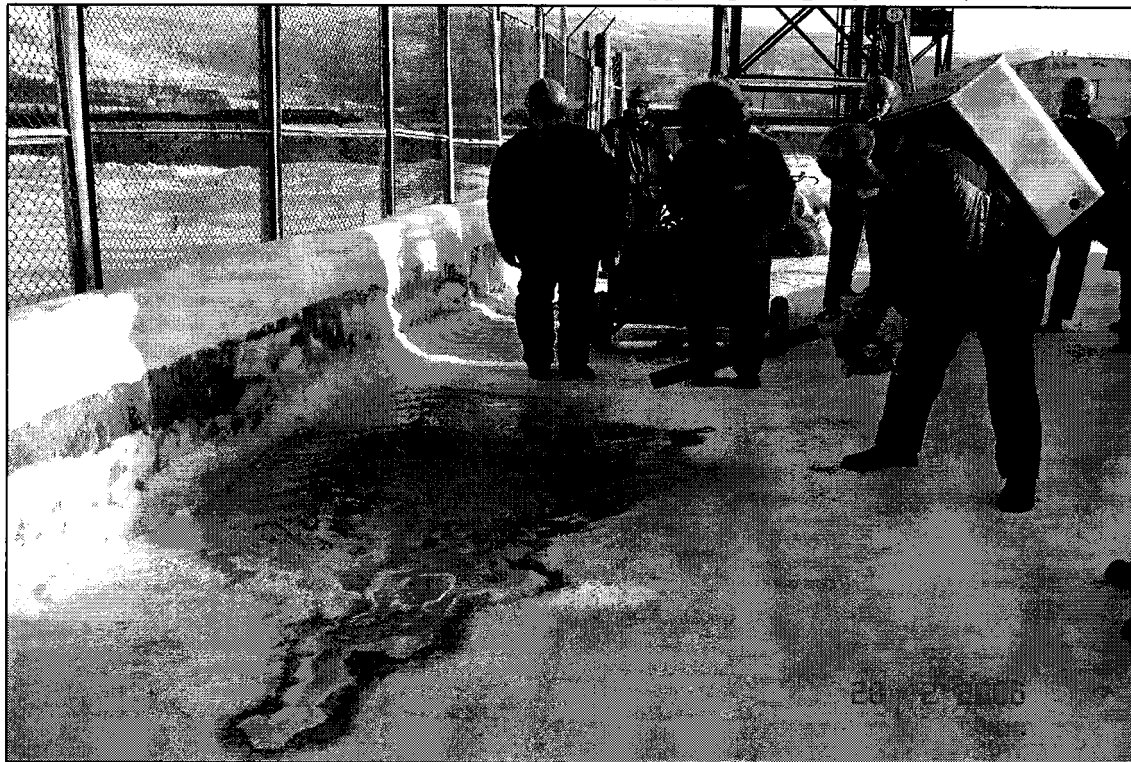
Рис. 3.7. Применение сорбента с помощью распылителя
