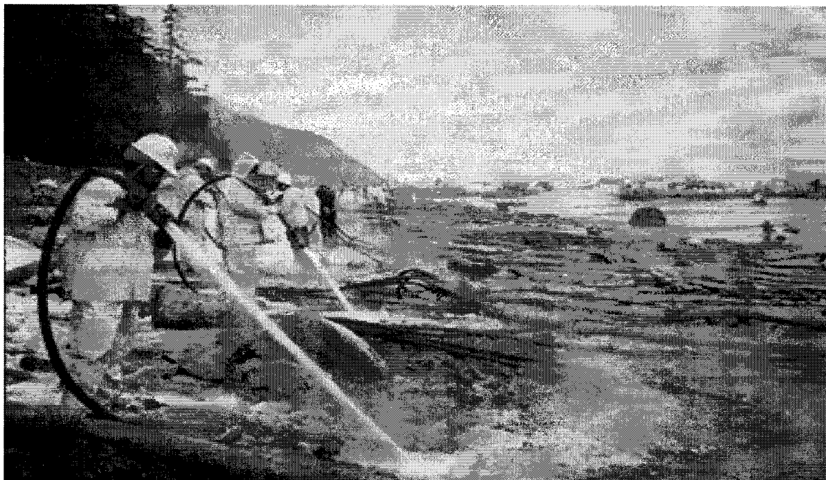
Рис. 3.9. Смыв нефтепродукта при высоком давлении
