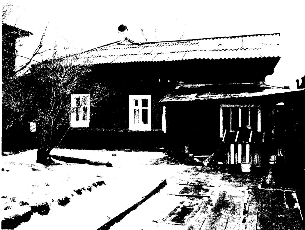
Фото №9 - Дворовой юго-западный фасад. Фото сделано 14 ноября 2006 года Бержинским И.Ю.
