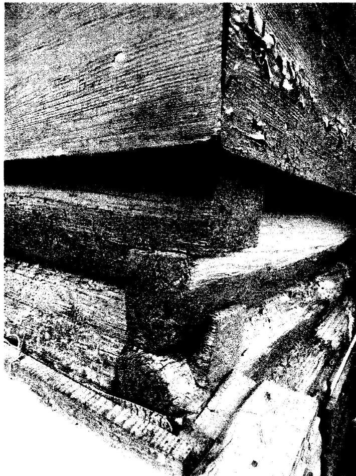
Фото №6 - Деревянные, рубленные «в лапу» стены
