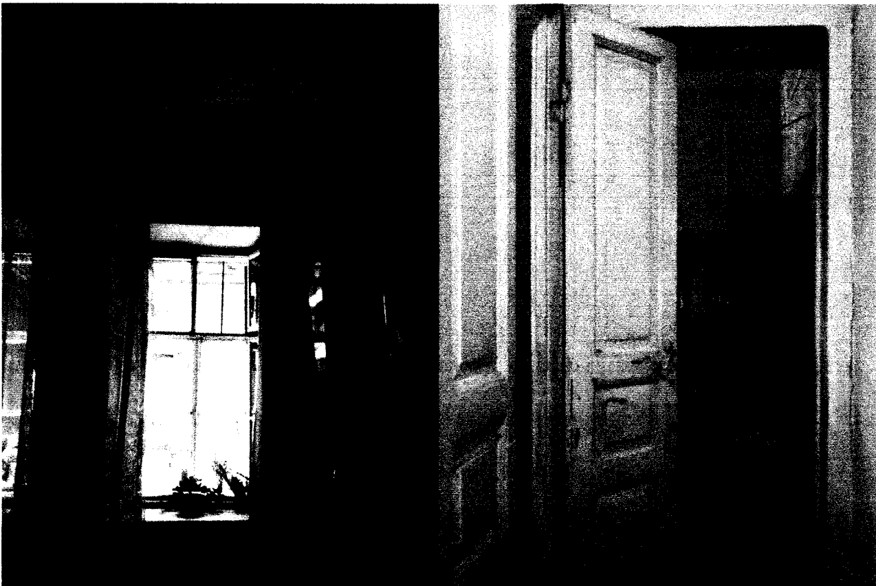
Фото 19, 20. Дворовый жилой пристрой. Дверные и оконные наличники. Двупольные двери. Фото 2013г.
