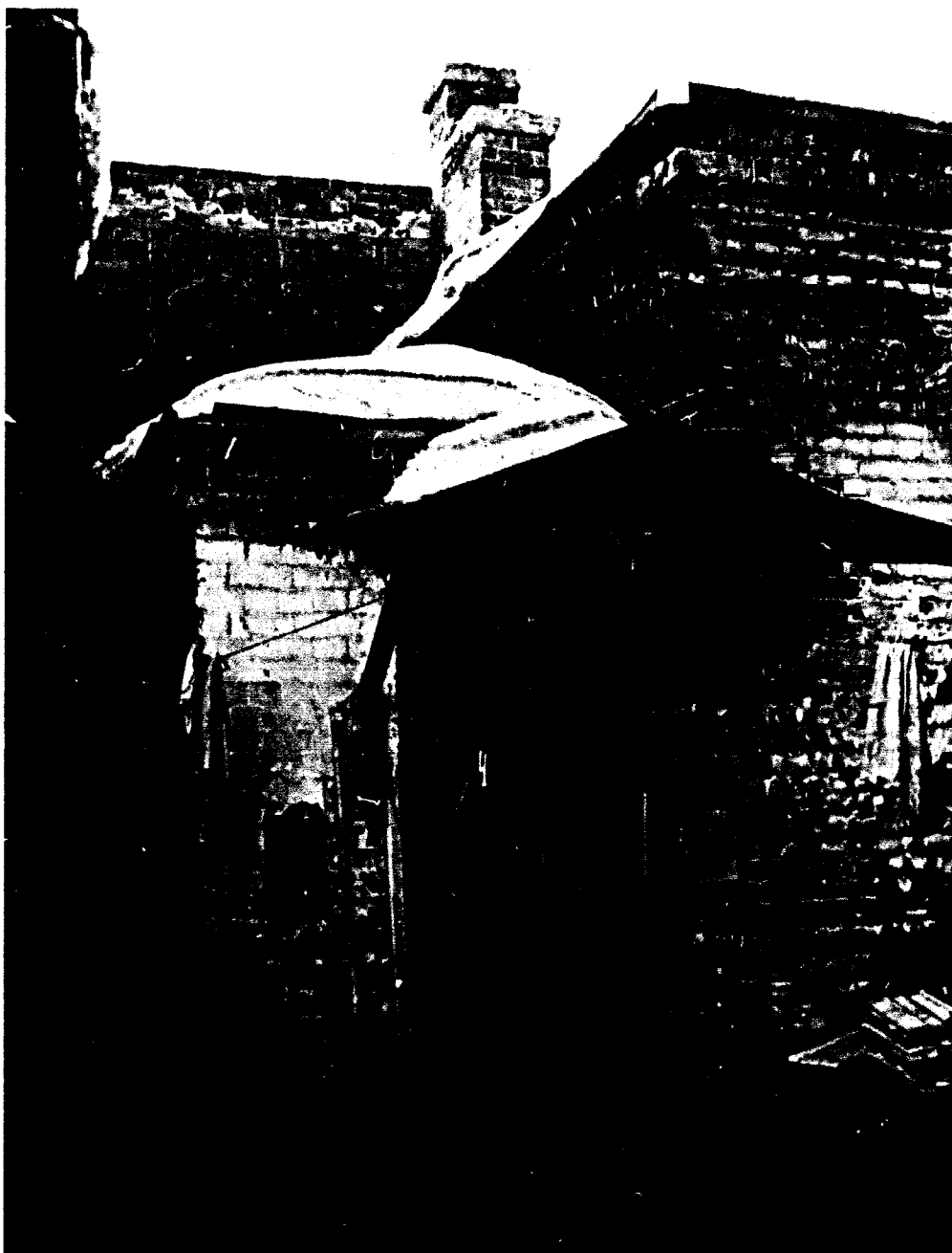
Фото 16. Входной пристрой. Козырек над входом
