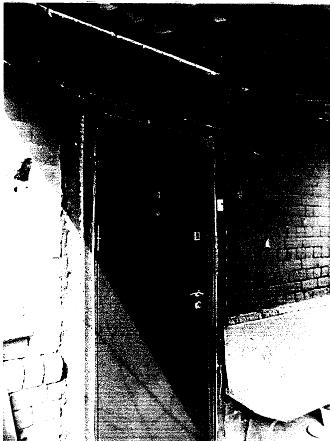
Фото 12. Входной пристрой. Дверной проем
