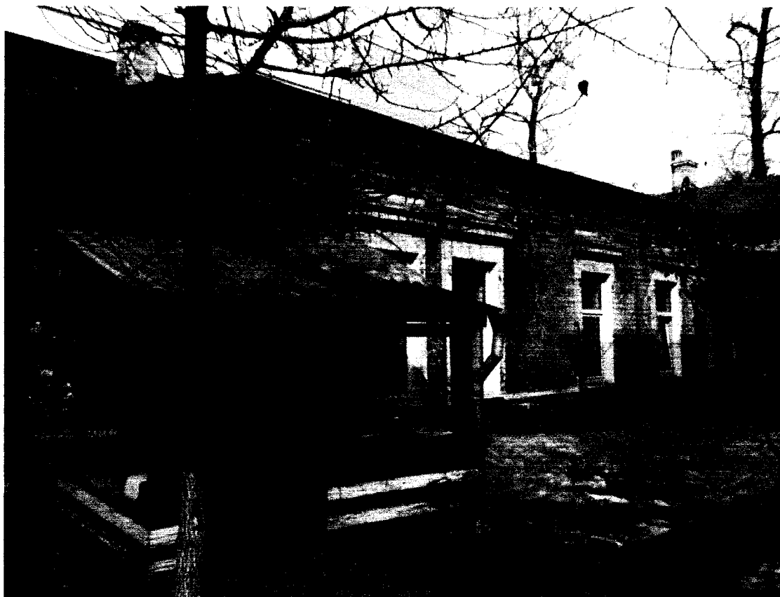
Фото 7. Дворовый жилой пристрой. Юго-восточный фасад
