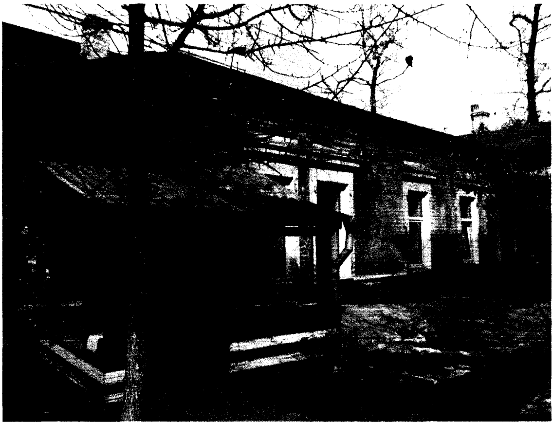
Фото 9. Дворовый жилой пристрой. Юго-восточный фасад
