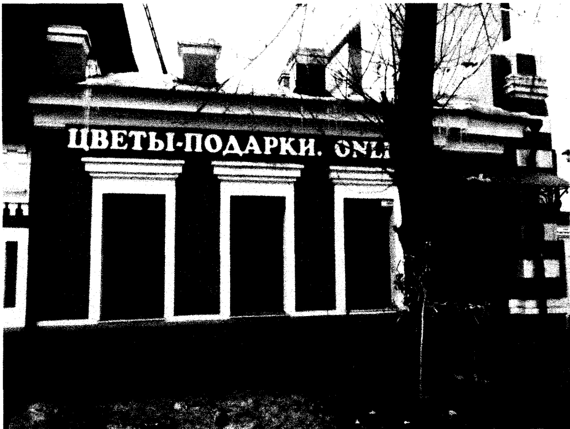
Фото 2. Главный (юго-восточный) фасад кирпичной лавки
