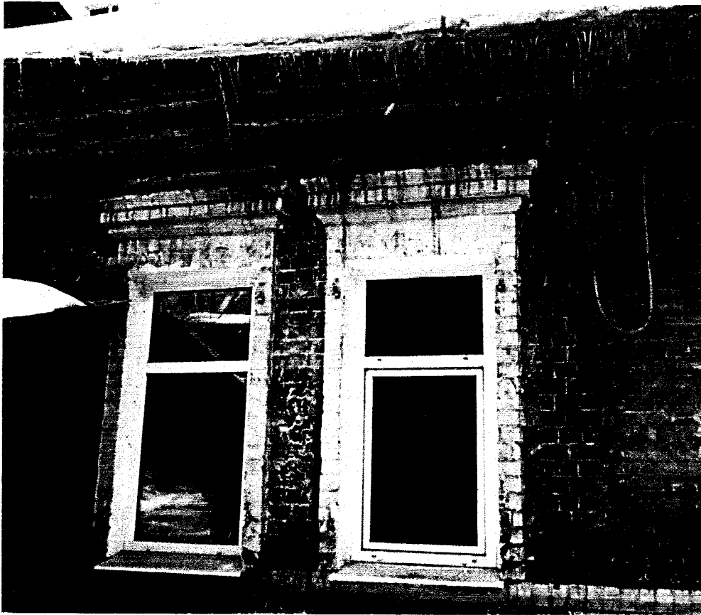
Фото 11. Дворовый жилой пристрой. Оконные проемы
