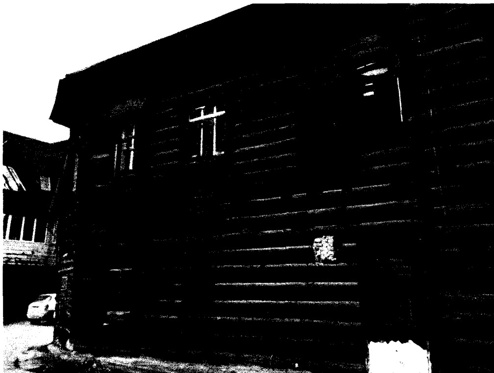
Фото 4. Боковой (юго-восточного) фасад основного объема
