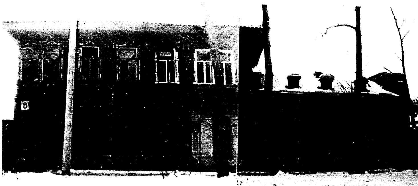
Фото 8. Главный (северо-восточный) фасад. Архив ЦСН
