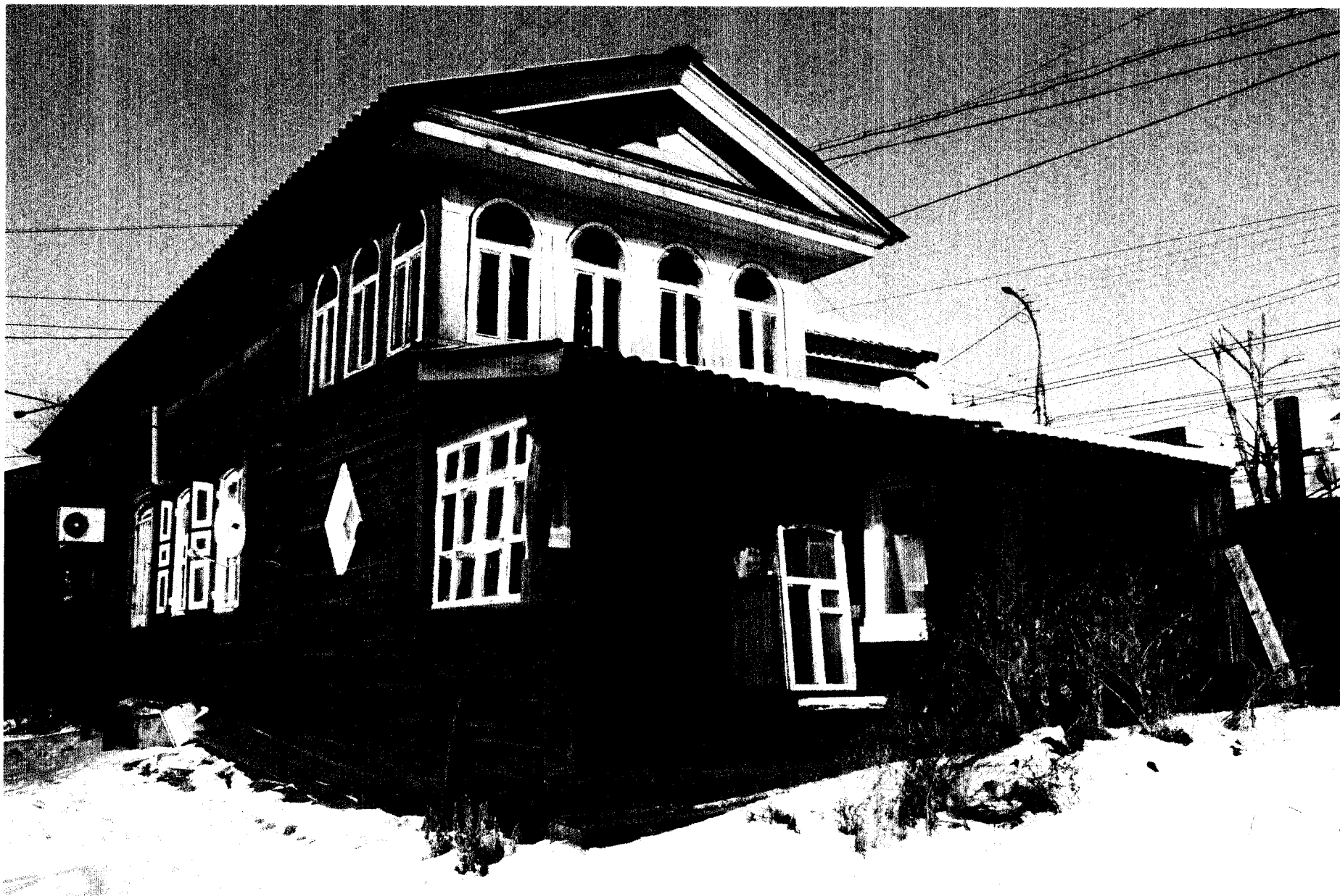
Фото 7 - Вид на здания с южного угла
