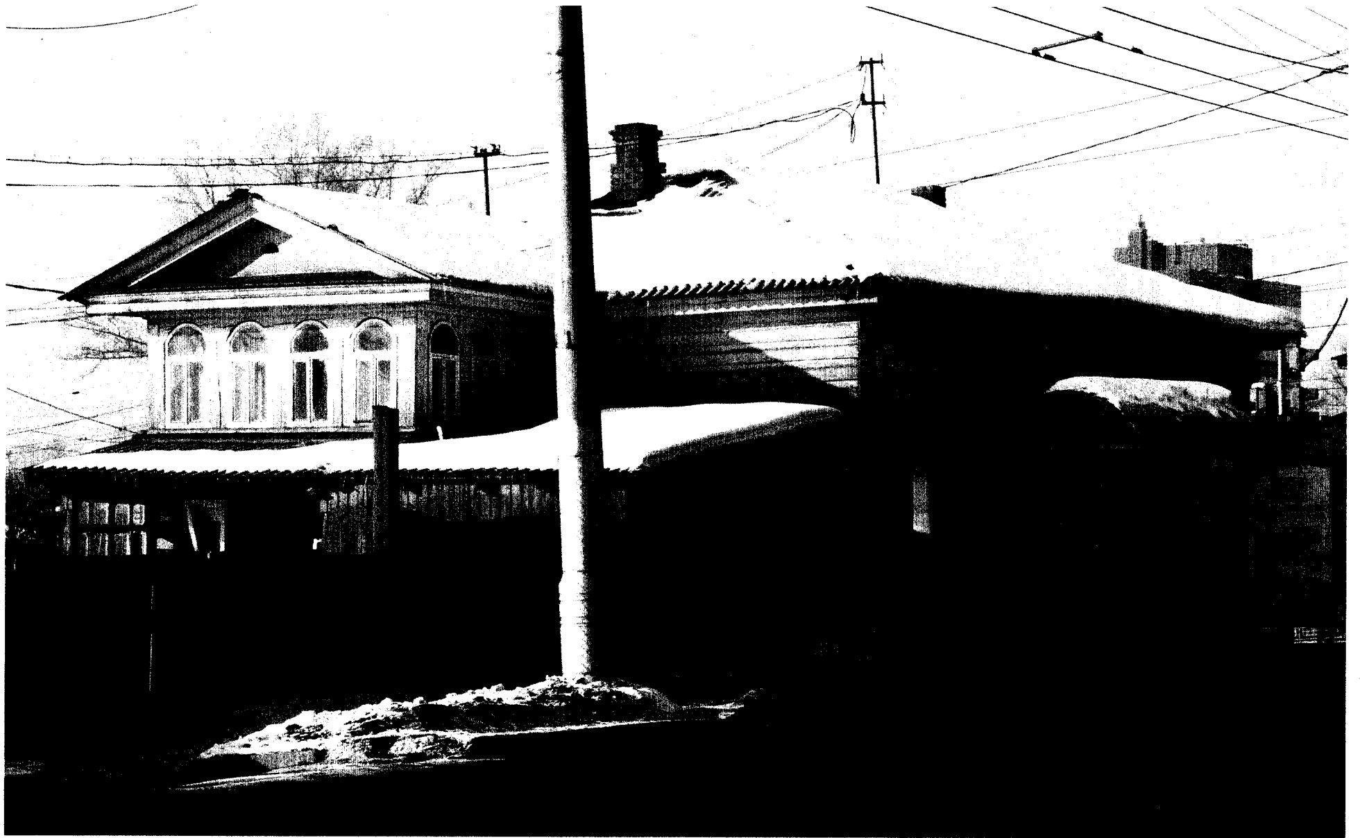
Фото 5 - Общий вид с юго-восточного угла
