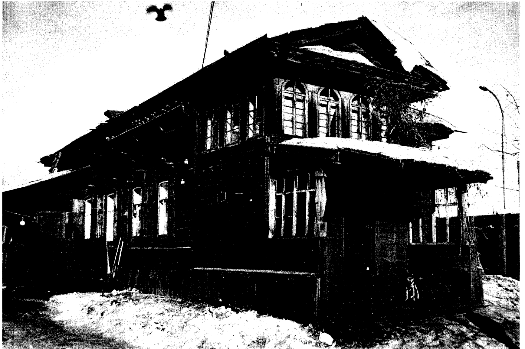
Фото 11 - Жилой дом XIX века. Вид со двора. Автор снимка: арх. В.Т. Щербин Дата съемки:1981г.
