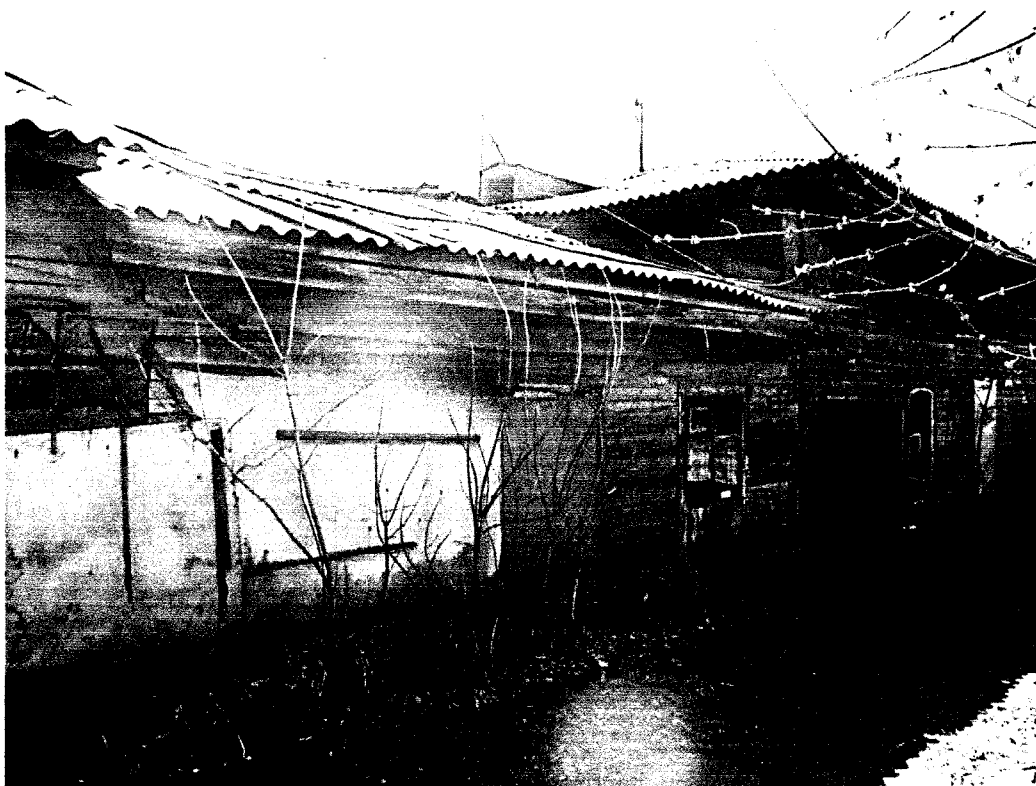
Фото 15 -Боковой (северо-западный) фасад здания лечебницы (лит.А, А1, А2). Пониженный прируб к основному объему лечебницы
