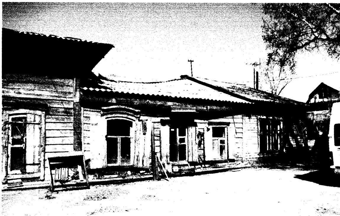
Фото 8 -Фрагмент бокового (юго-восточного) фасада лечебницы (лит.А, А1, А2). Пониженный прируб
