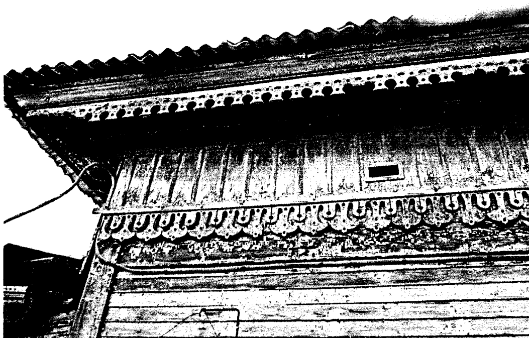
Фото 4 -Фрагмент главного (юго-западного) фасада лечебницы (лит.А, А1, А2). Фриз, карниз основного объема
