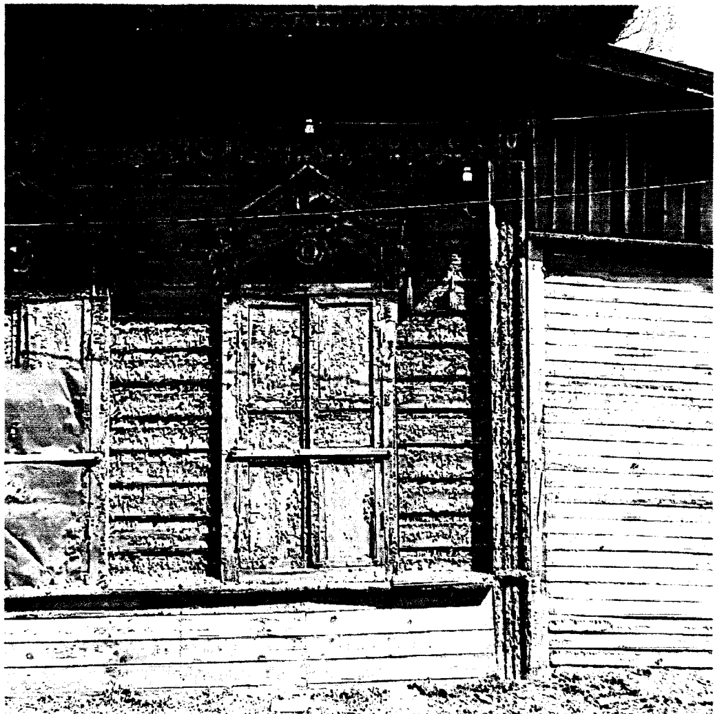
Фото 5 -Фрагмент главного (юго-западного) фасада лечебницы (лит.А, А1, А2). Наличник окна, лопатка, обшивка основного объема
