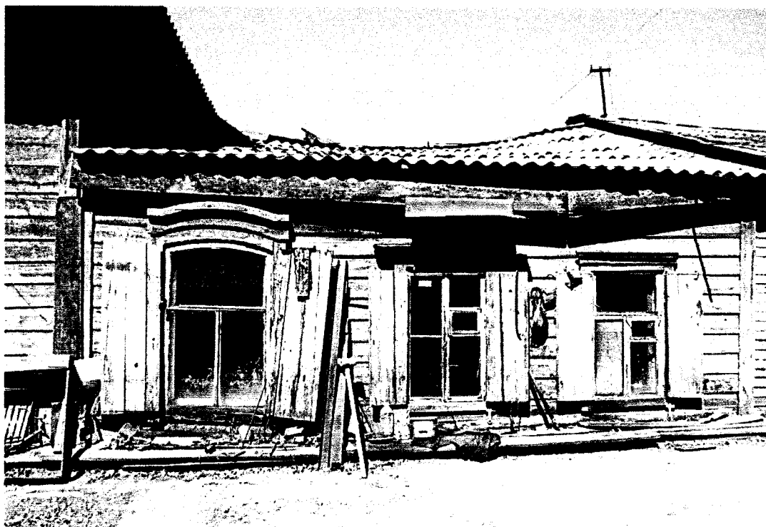
Фото 10 -Фрагмент бокового (юго-восточного) фасада пониженного прируба к основному объему лечебницы (лит.А, А1, А2)
