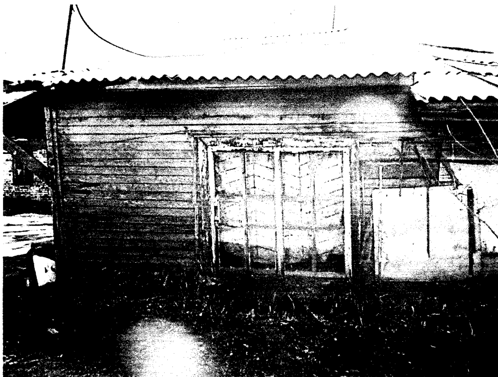
Фото 14 -Боковой (северо-западный) фасад здания лечебницы (лит.А, А1, А2). Поздний перестроенный дворовый пристрой
