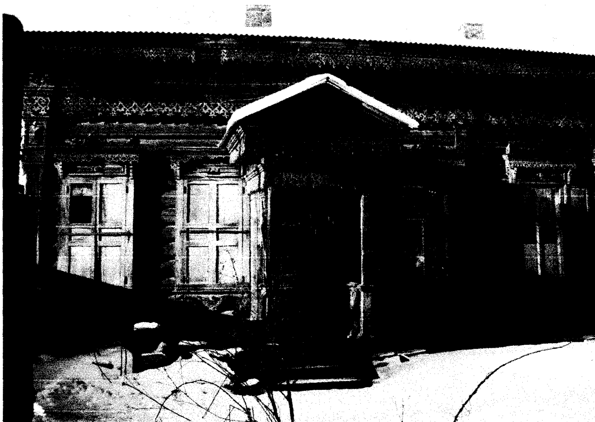
Фото 2 - Боковой (юго-восточный) фасад жилого дома (лит. А.). Основной объем
