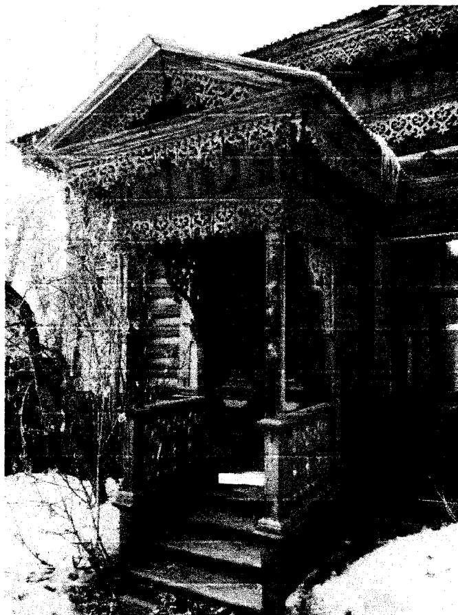
Фото 12 - Парадное крыльцо основного объема (юго-восточный фасад)
