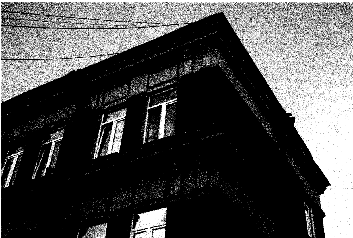
Фото 13 - Южный угол здания. Межэтажный пояс с карнизом. Фризовый пояс
