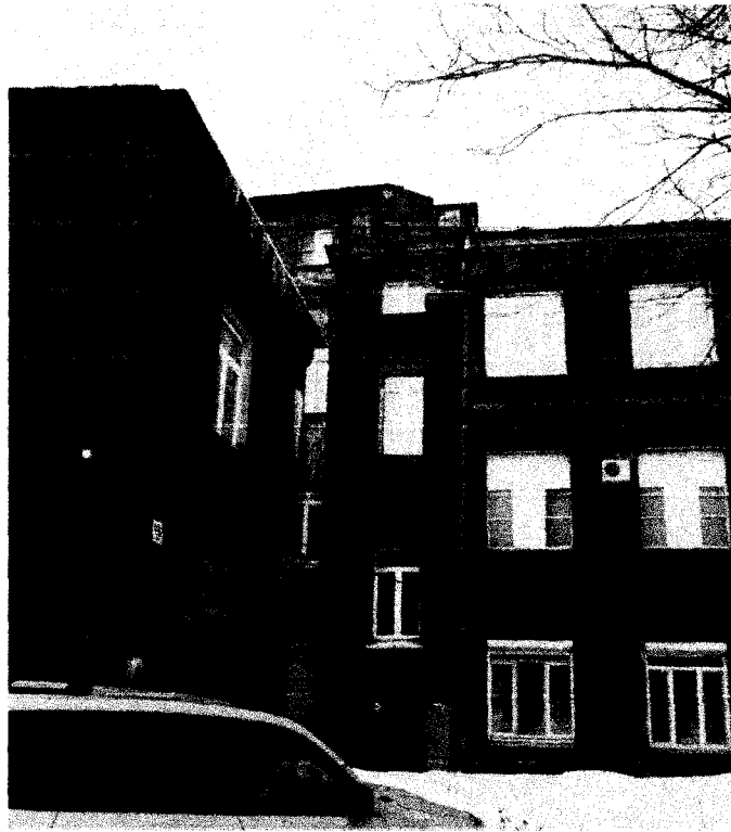
Фото 23 - Лестничный блок дворового крыла: аттиковая стенка с щипцом
