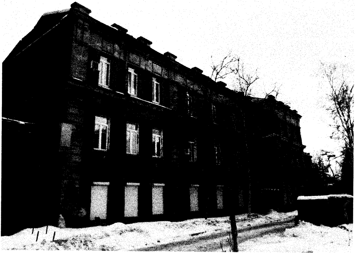
Фото 5 - Фрагмент бокового (северо-западного) фасада. Вид с севера
