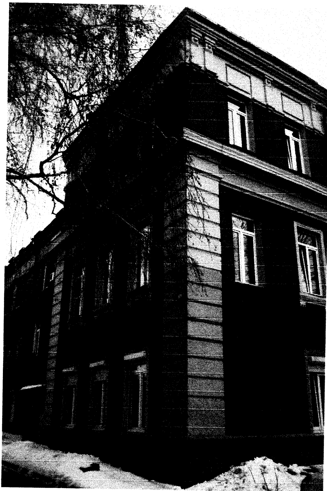
Фото 19 - Западный угол левого крыла. Огибающая угловая лопатка. Межэтажные пояса
