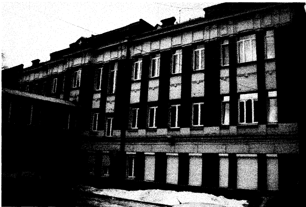
Фото 1 - Фрагмент главного (юго-западного) фасада. Вид с юга. Галерея, соединяющая здание с корпусом лит. А
