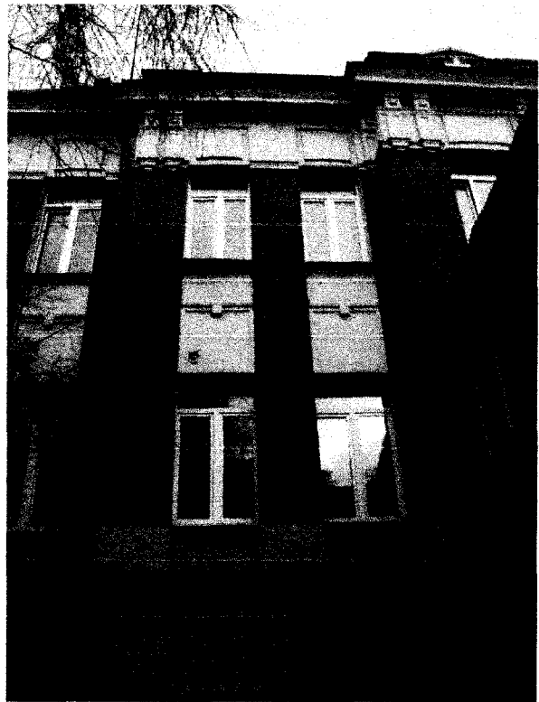
Фото 15 - Фрагмент главного фасада основного корпуса. Оконные проемы 1 и 2 этажей. Межэтажные пояса
