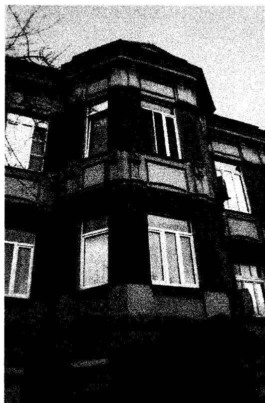
Фото 4 - Фрагмент главного фасада, эркер по центральной оси. Межэтажные и фризový пояса
