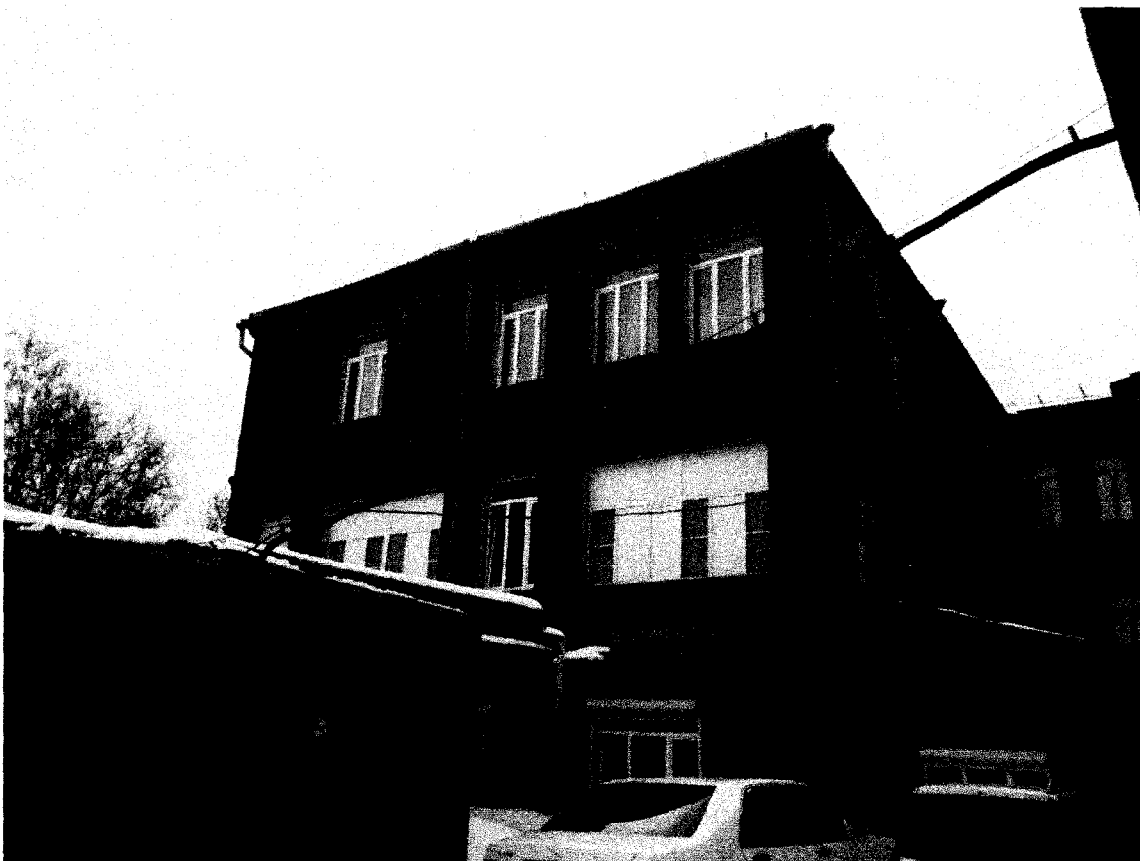
Фото 10 - Северо-восточный фасад дворового крыла. Эркер в 1 этаже
