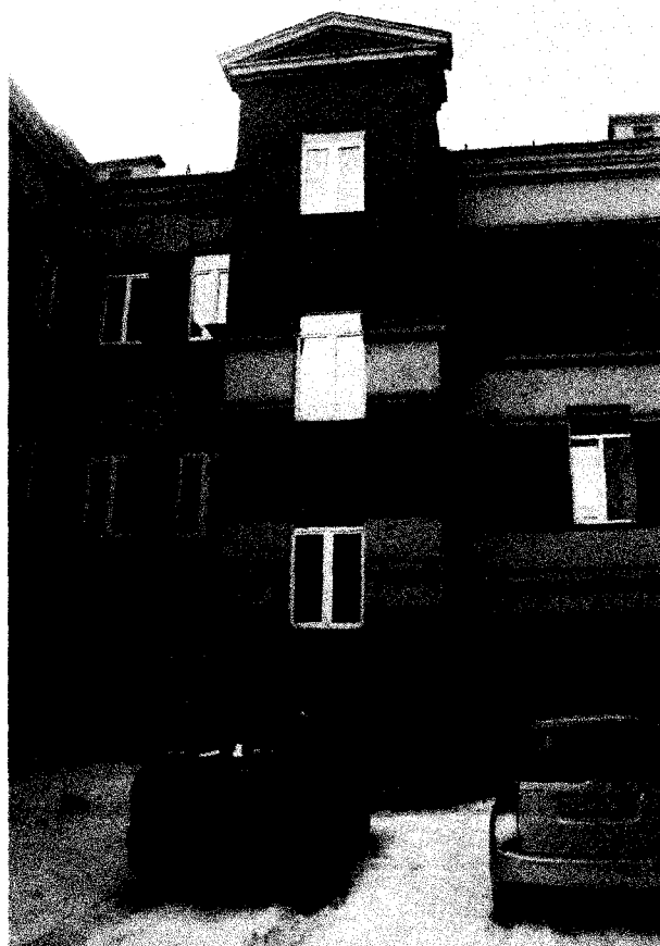
Фото 10 - Ризалит лестничного блока на юго-восточном фасаде
