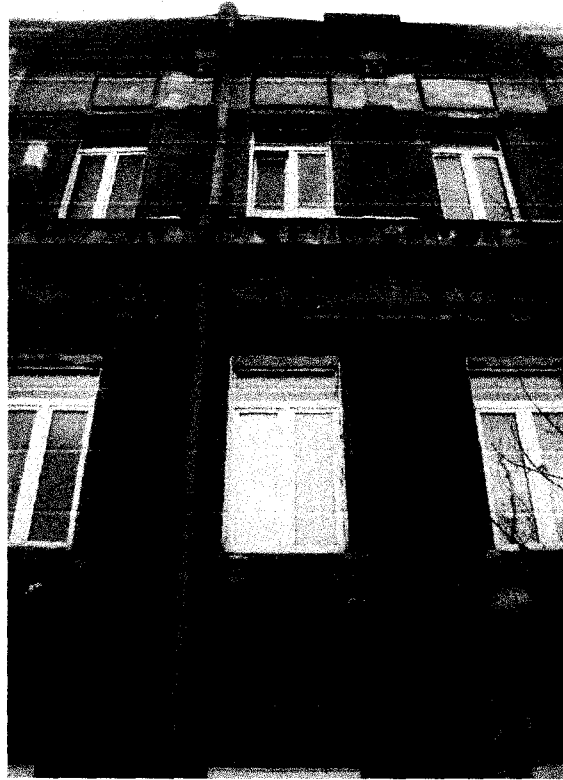
Фото 21 - Фрагмент бокового фасада левого крыла: оконные проемы 2 и 3 этажей
