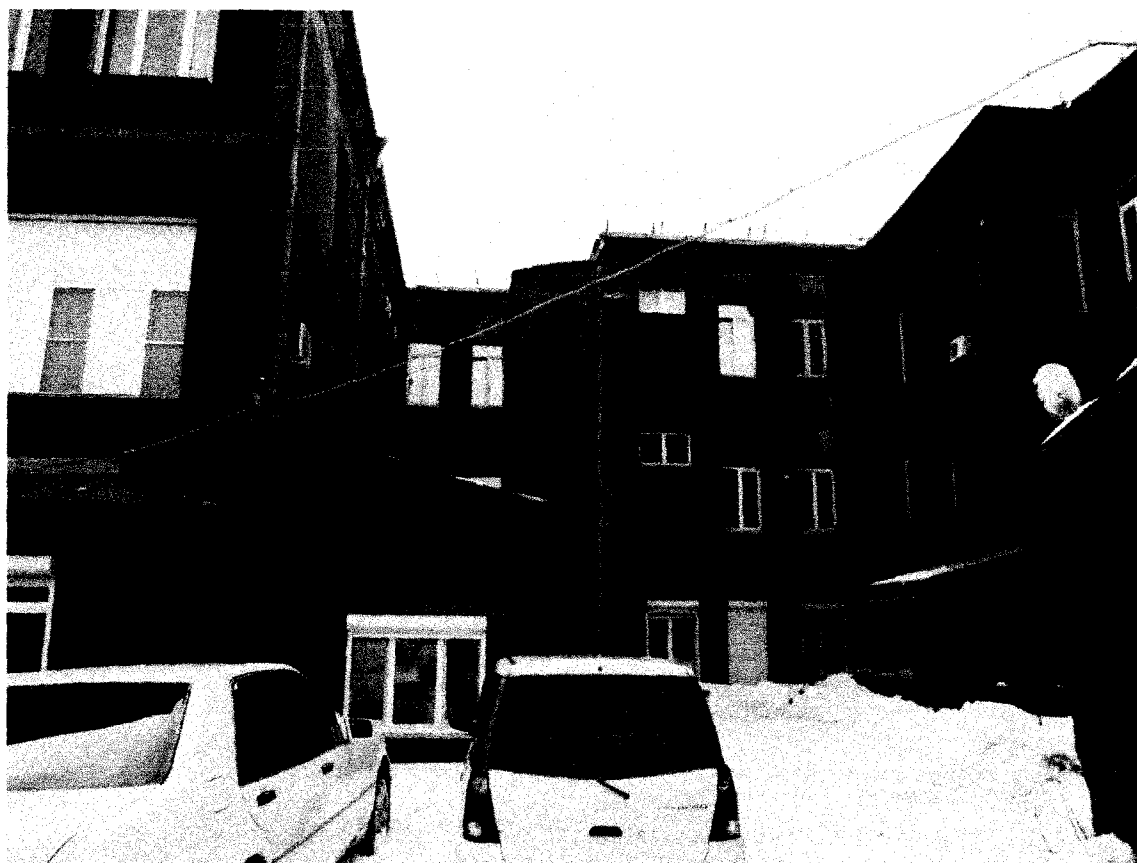
Фото 8 - Фрагмент дворового (северо-восточного) фасада основного корпуса. Оконный проем раскрытый до дверного.
