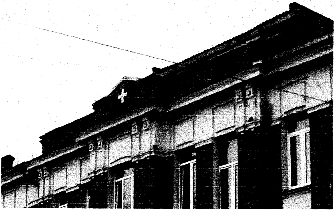
Фото 16 - Аттиковая стенка, венчающая ризалит на главном фасаде. Фриз, карниз
