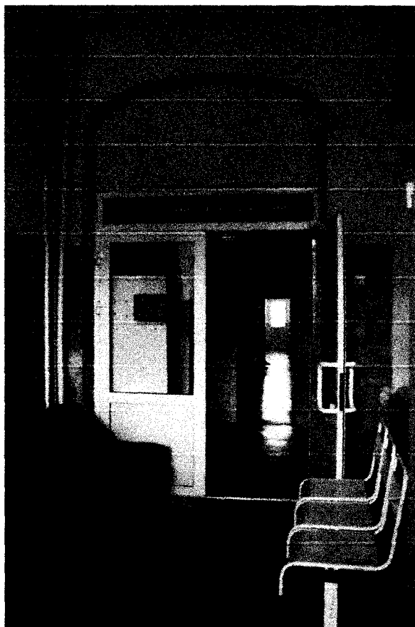
Фото 24 - Арочный проем в пом. №44 1 этажа
