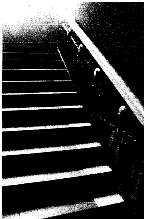
Фото 27 - Фрагмент трёхмаршевой лестницы в пом. №44
