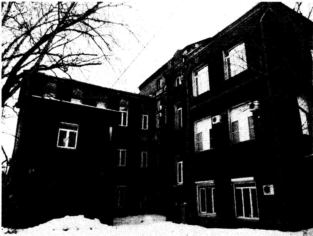
Фото 12 - Общий вид на здание с востока. Фрагмент дворового фасада основного корпуса, боковой (юго-восточный) фасад дворового крыла
