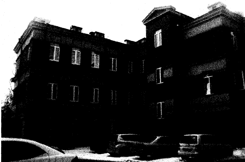
Фото 9 - Общий вид на здание с востока
