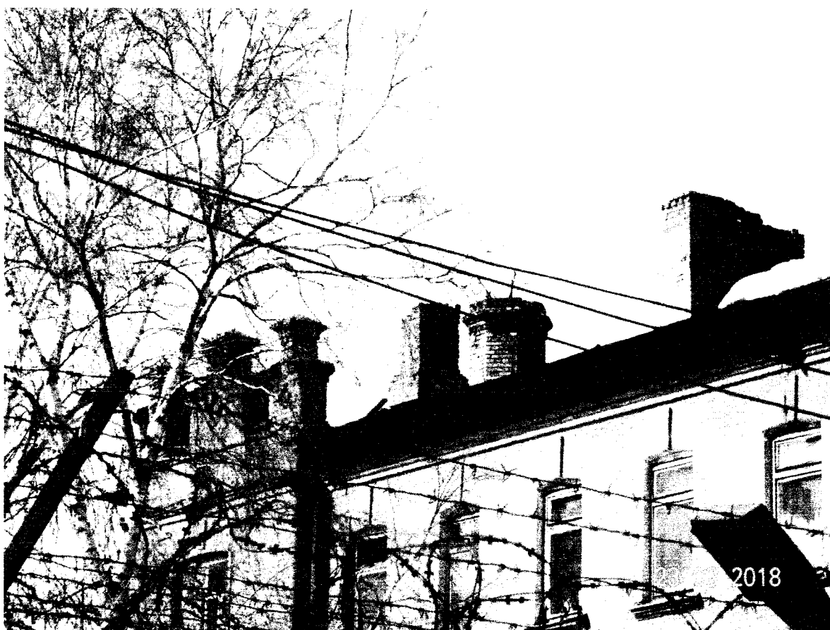
Фото 22 - Дымовые и вентиляционная трубы
