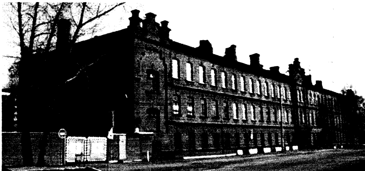
Фото 7 - Общий вид северо-западного фасада
