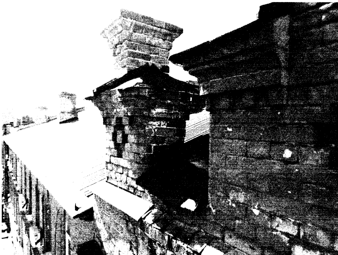
Фото 21 - Фрагмент аттиковой стенки на правом ризалите дворового фасада
