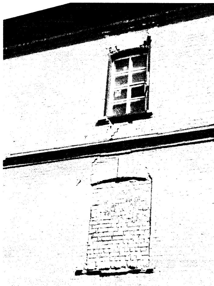
Фото 26 - Окна и пояски юго-западного фасада
