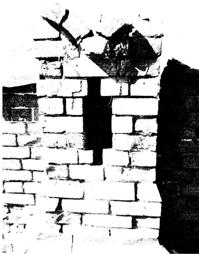
Фото 20 - Мерлон («ласточкин хвост») на центральном ризалите дворового фасада
