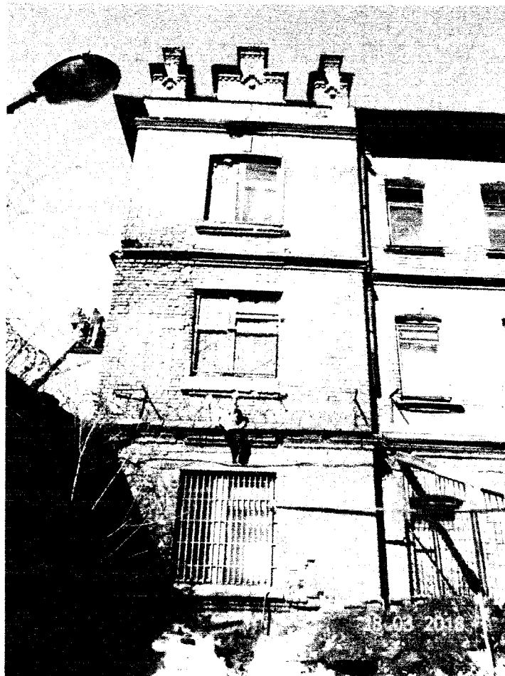
Фото 16 - Левый ризалит юго-восточного (дворового) фасада
