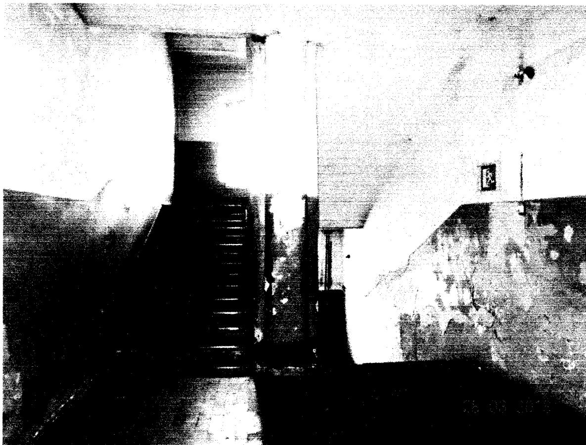
Фото 38. Лестница левого ризалита. Площадка второго этажа.
