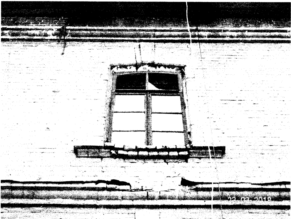
Фото 24 - Окно с выступающим замковым камнем, междуэтажный, подкарнизный и подоконный пояс на боковом северо-восточном фасаде
