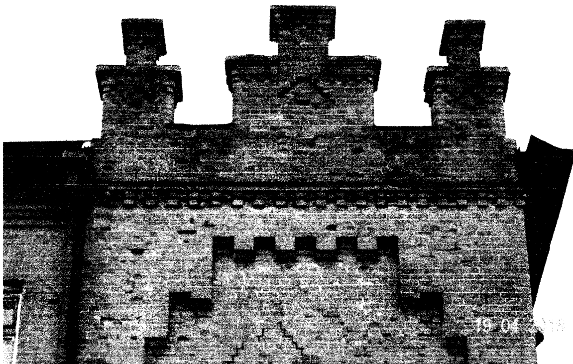
Фото 13 - Аттиковая стенка правого ризалита северо-западного (главного) фасада
