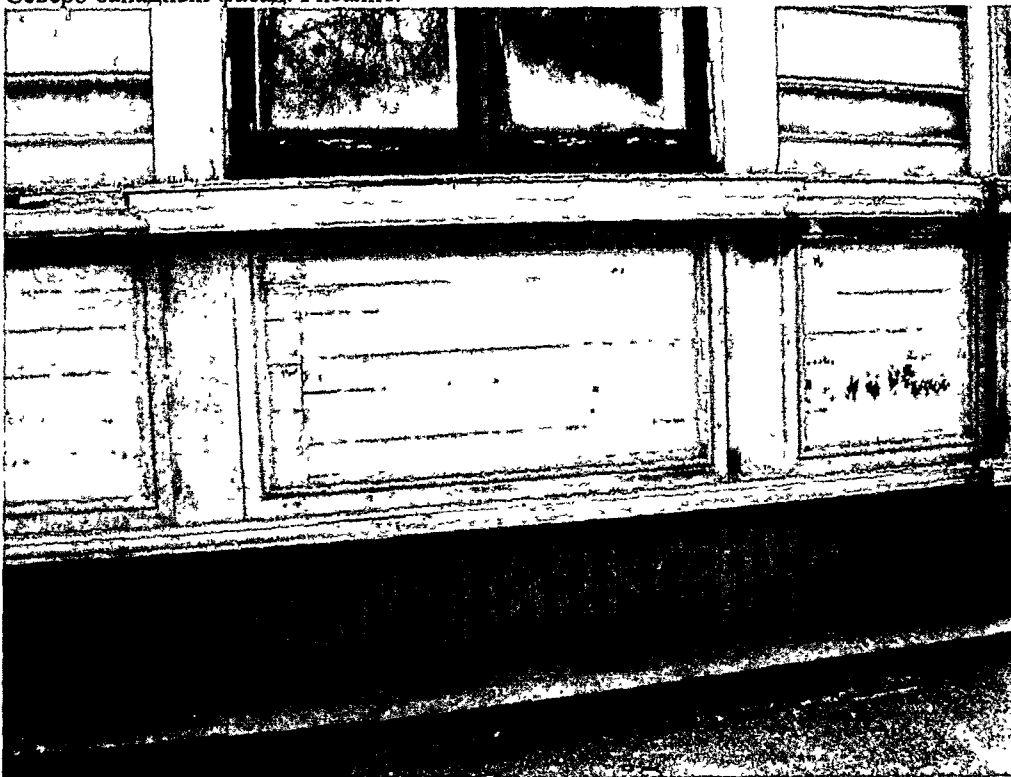
Северо-западный фасад. Цоколь, подоконная часть.
