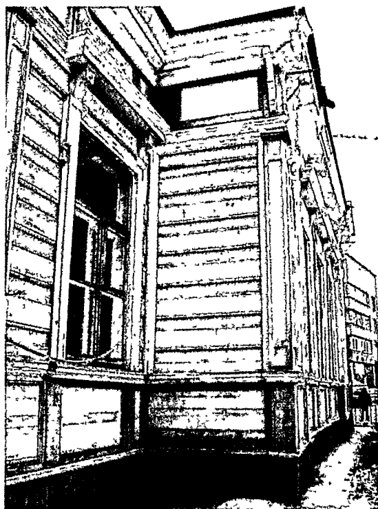
Юго-западный фасад. Угол ризалита.
