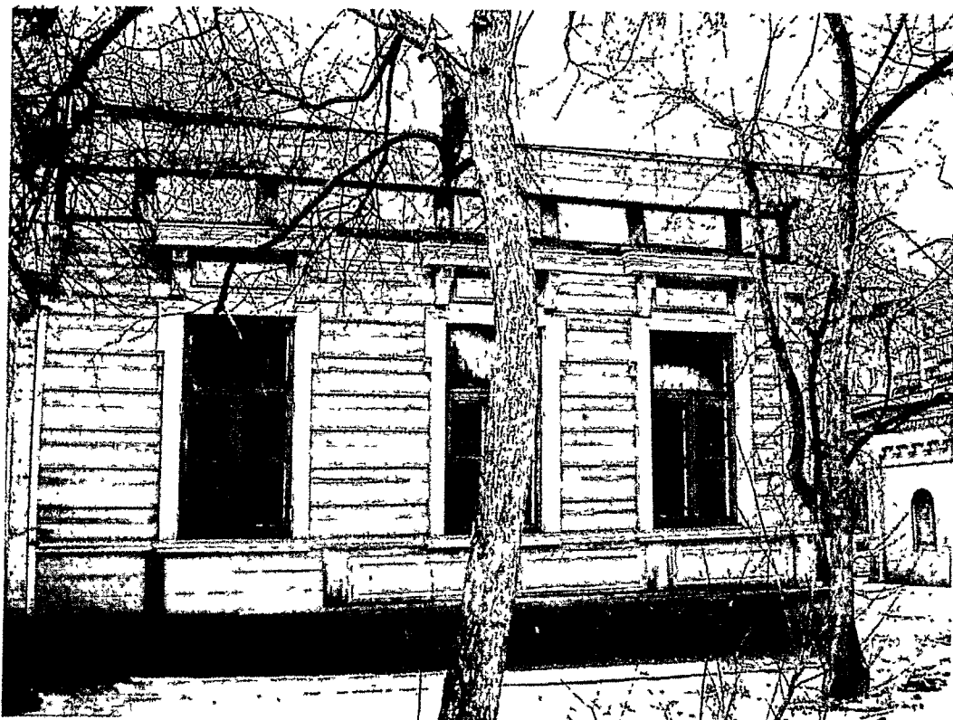
Юго-восточный фасад. Пристрой отделенный от основного объема кирпичной стеной.
