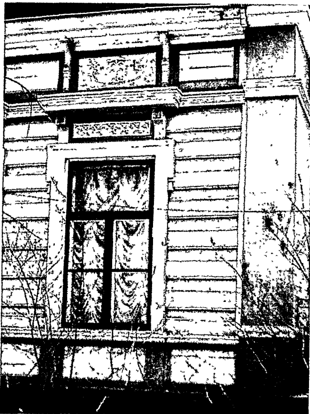
Северо-западный фасад. Наличник окна пристроя.
