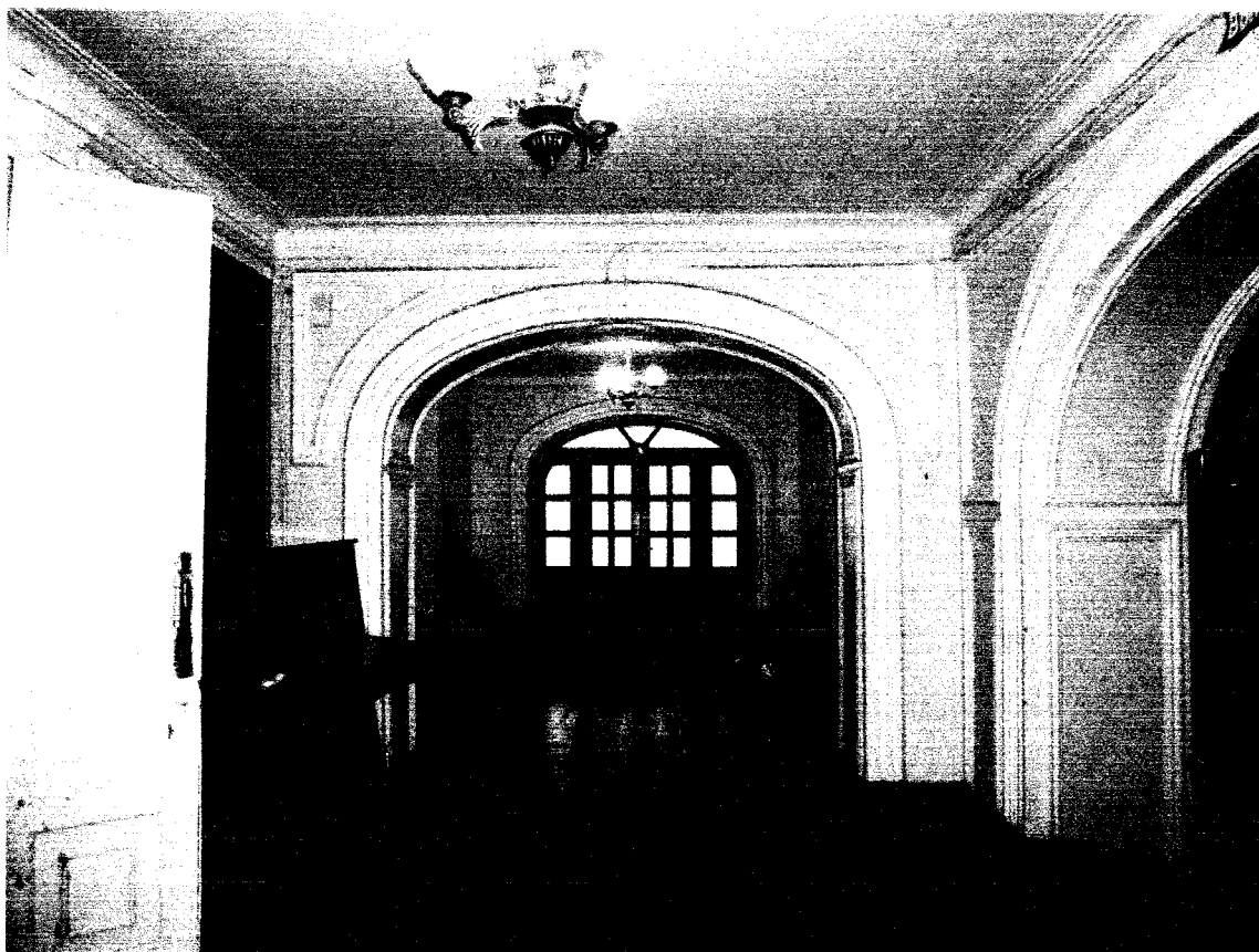
Фото 76 - Второй этаж. Помещение 10
