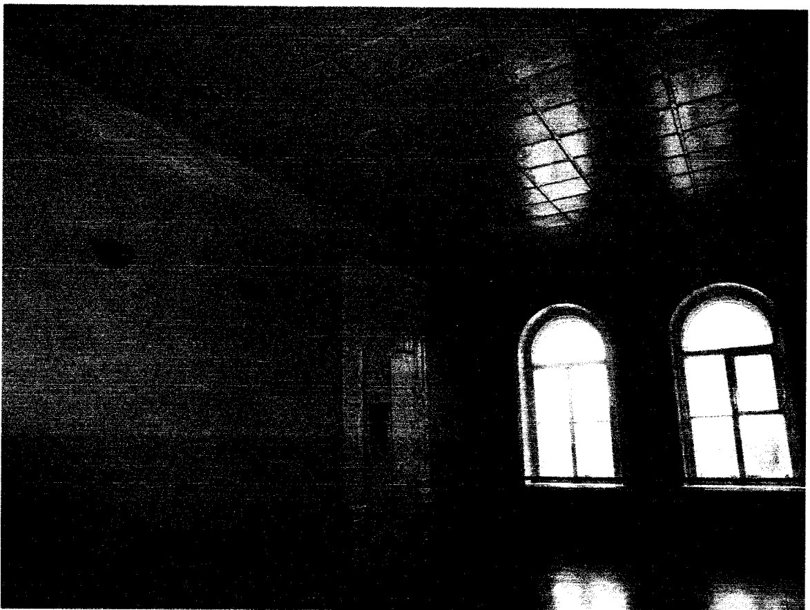
Фото 70 - Второй этаж. Помещение 3
