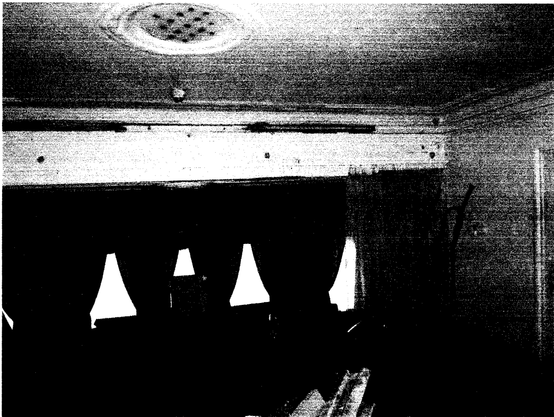
Фото 99 - Антресольный этаж. Помещение 3. Галтель потолка и розетка потолка
