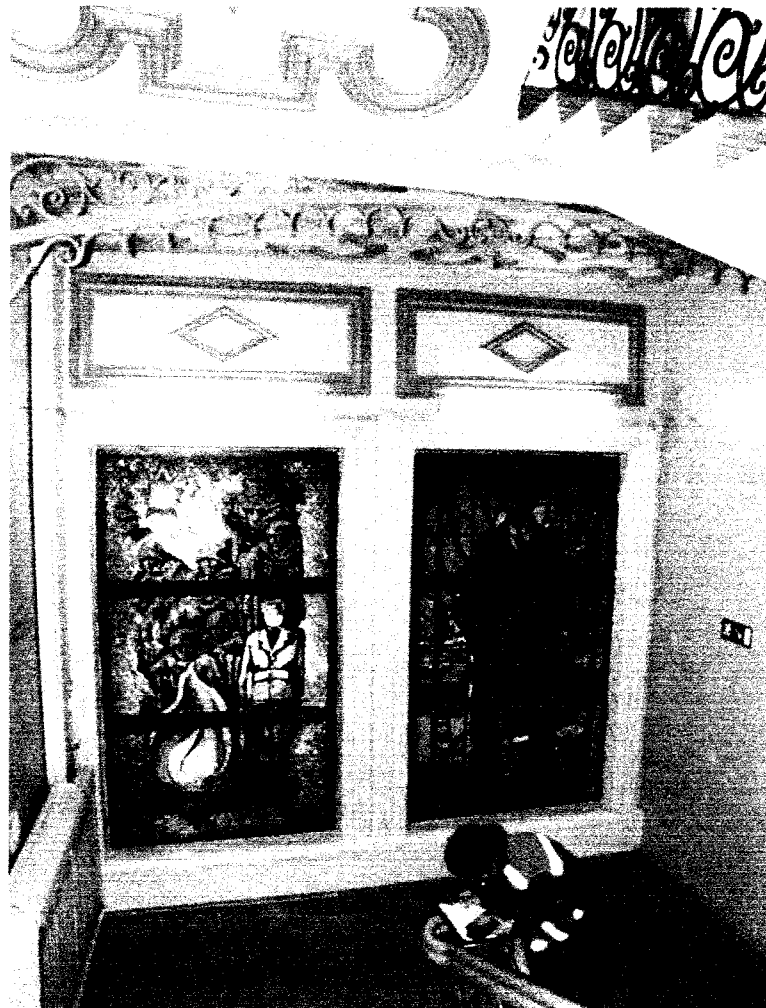
Фото 74 - Второй этаж. Помещение 8
