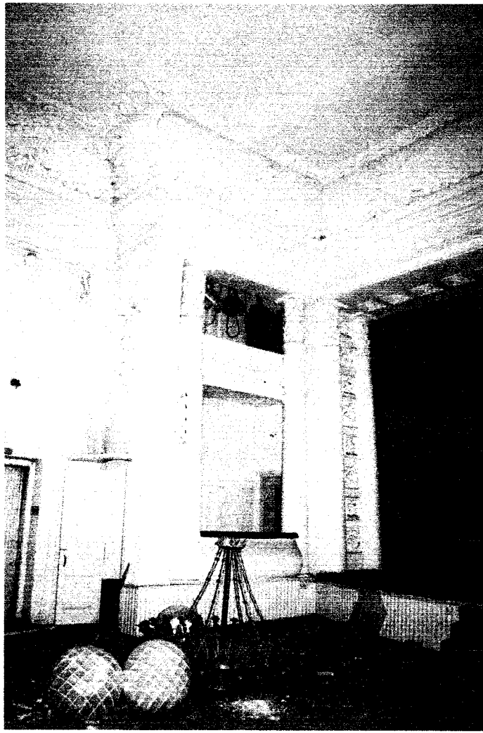
Фото 87 - Второй этаж. Помещение 21. Большой зал
