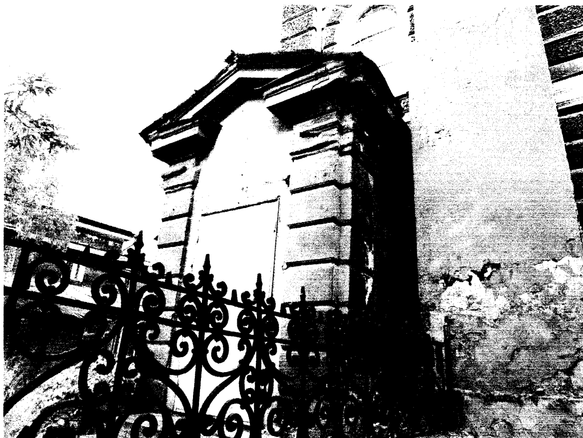
Фото 22 - Одноэтажный тамбур входа
