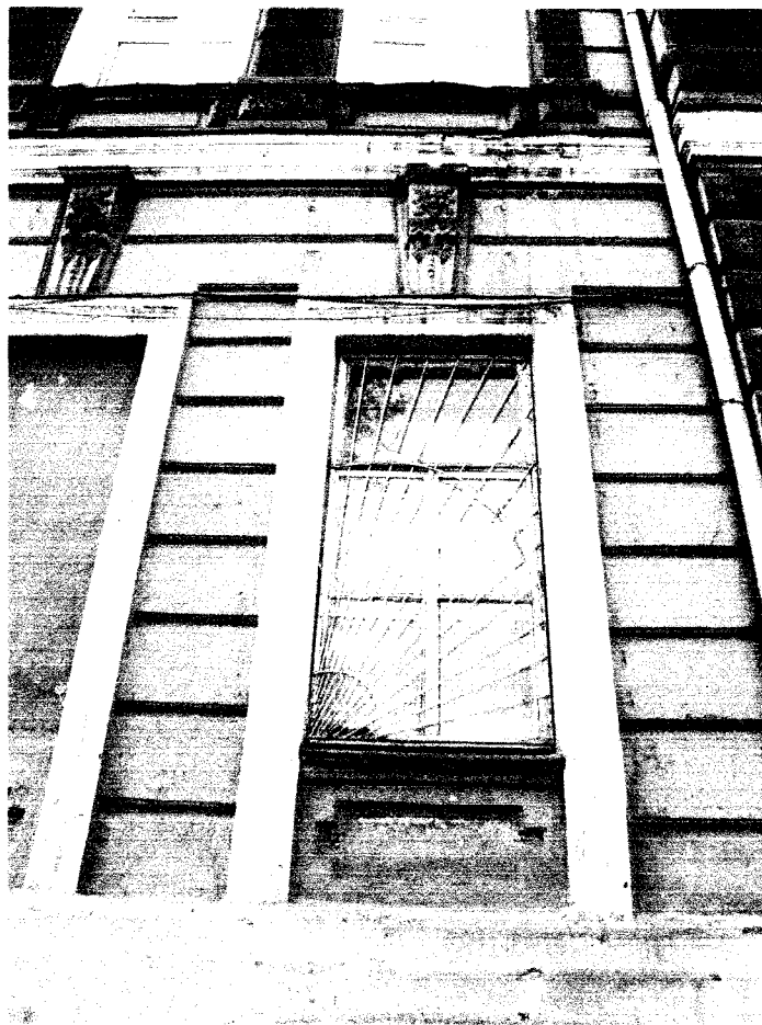
Фото 19 - Окно и ниша первого этажа с фигурным замковым камнем
