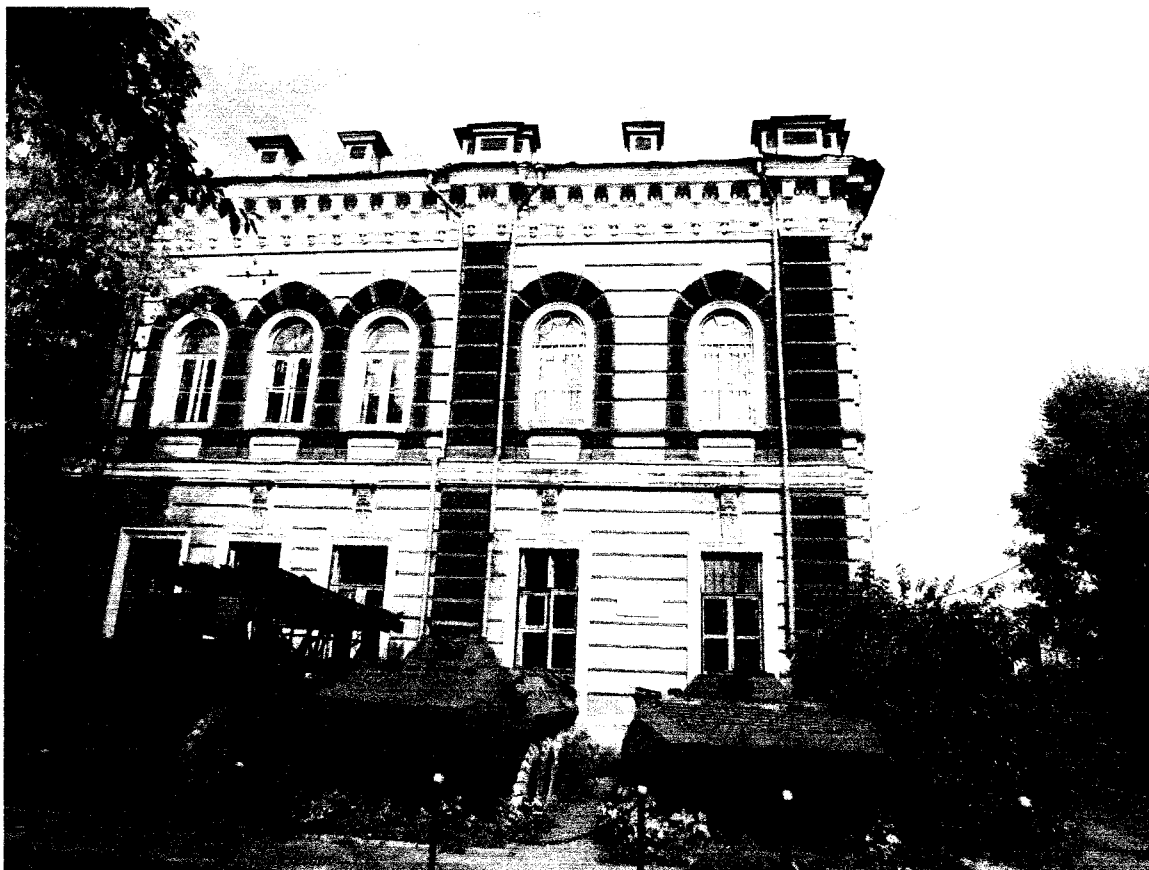
Фото 21 - Боковой юго-западный фасад (фрагмент)
