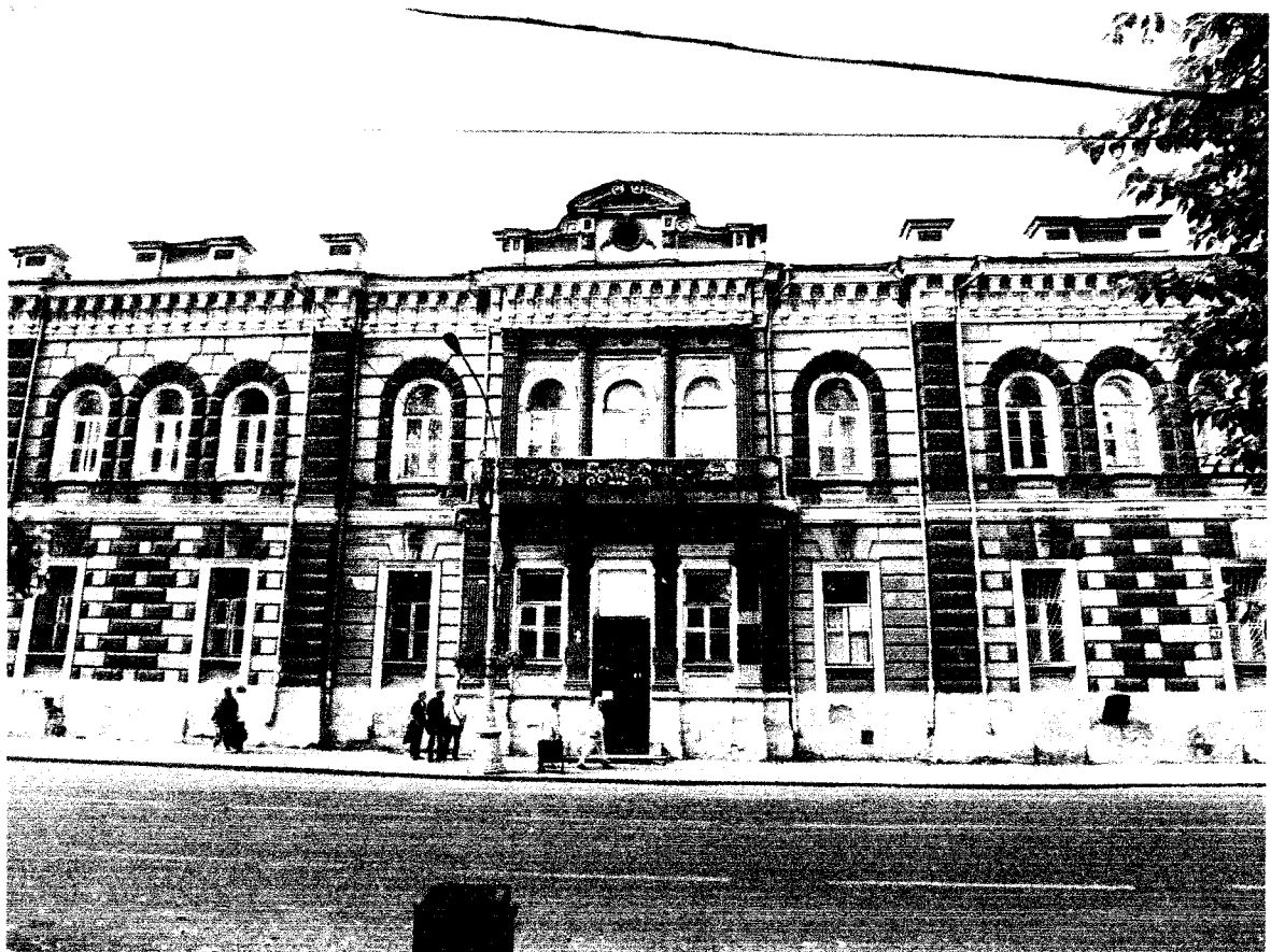
Фото 4 - Главный (юго-восточный) фасад с ул. К.Маркса
