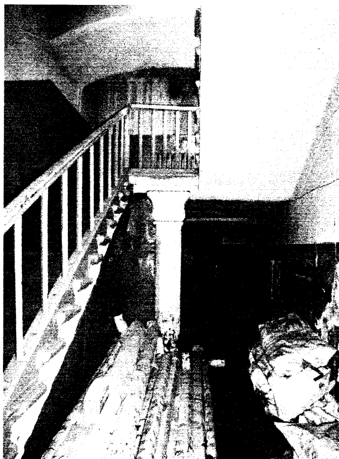
Фото 58 - Первый этаж. Помещение 25 черная лестница
