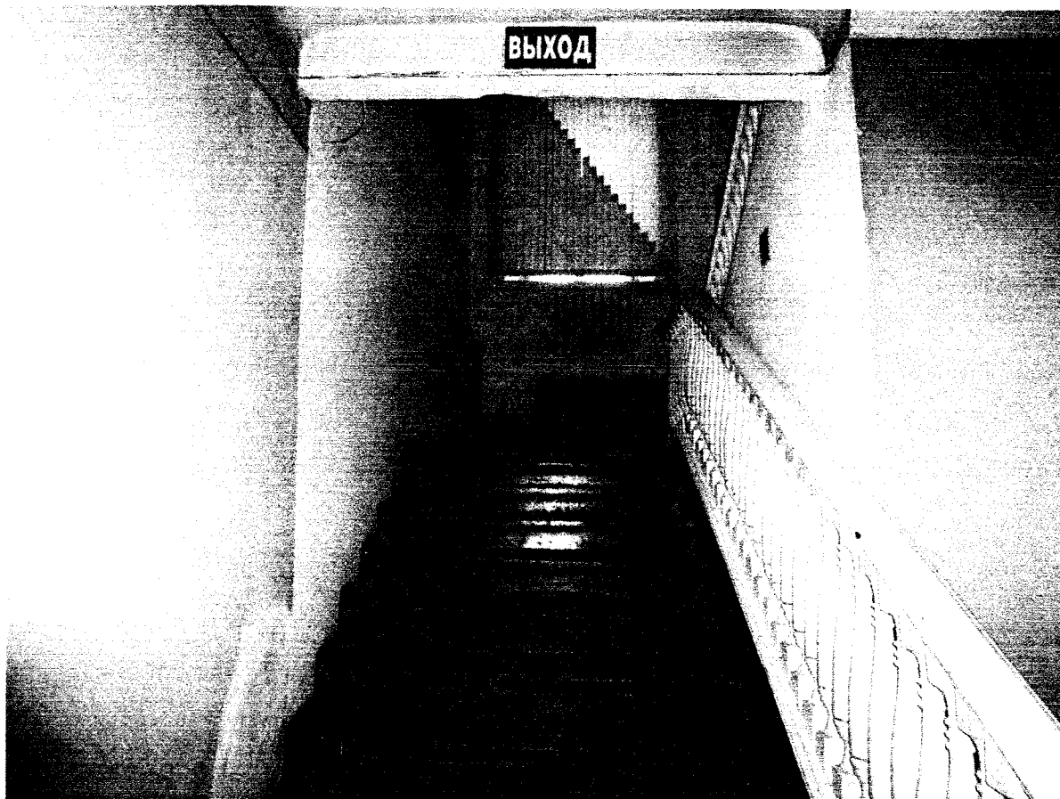
Фото 42 - Лестница из подвала в вестибюль
