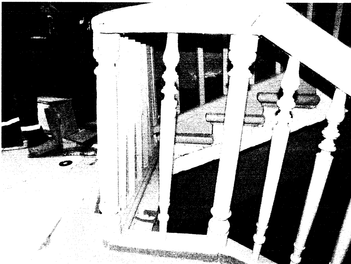
Фото 83 - Второй этаж. Помещение 16. Ограждение черной лестницы
