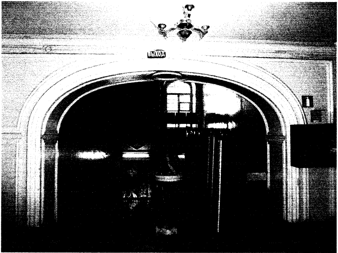
Фото 77 - Второй этаж. Помещение 10. Коробовая арка
