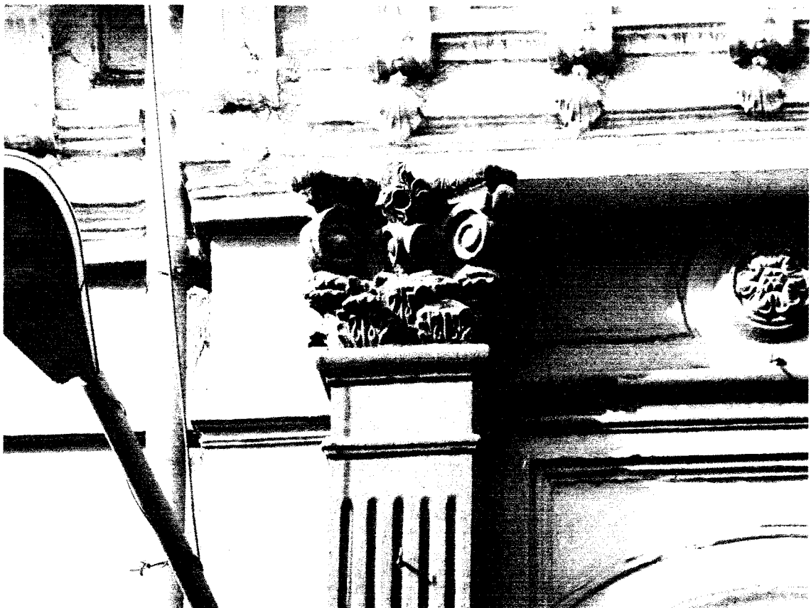
Фото 6 - Угловая пилястра среднего ризалита, заполнение антревольтов второго этажа
