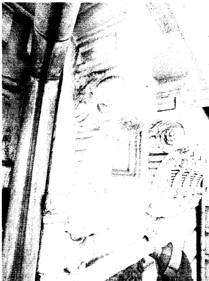
Фото 8 - Модульоны и кронштейны на фризе
