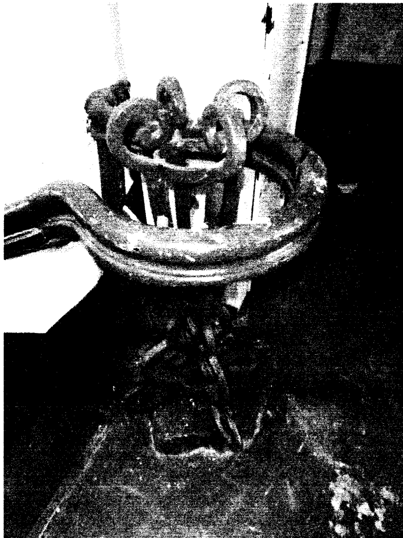
Фото 97 - Антресольный этаж. Помещение 1. Перила ограждения
