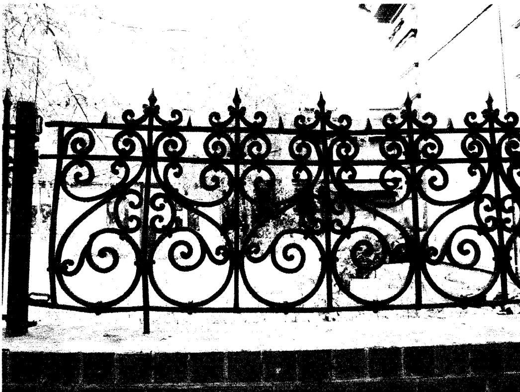
Фото 2 - Кованое заполнение ограды на столбах со стороны ул.К.Маркса
