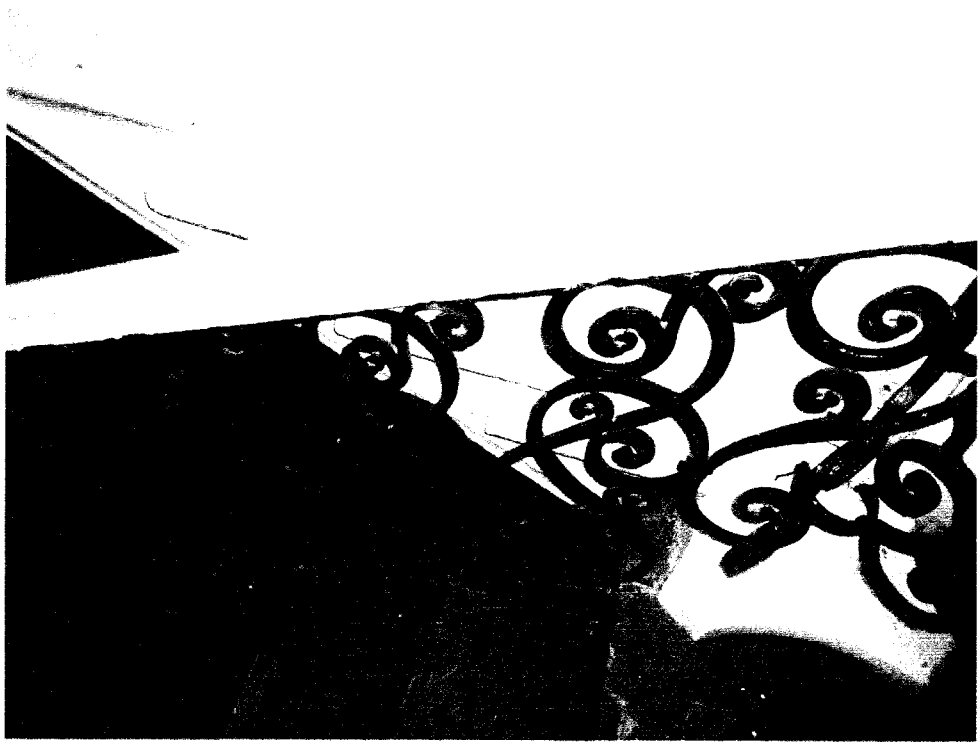
Фото 96 - Антресольный этаж. Помещение 1. Ограждение лестницы
