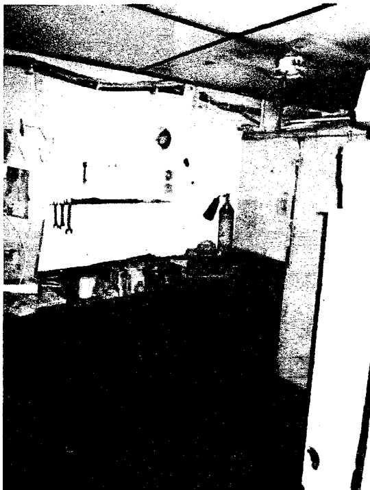
ПРИЛОЖЕНИЕ 2. ФОТОФИКСАЦИЯ. Фото 42,43 Техническое помещение в трюме корабля.
