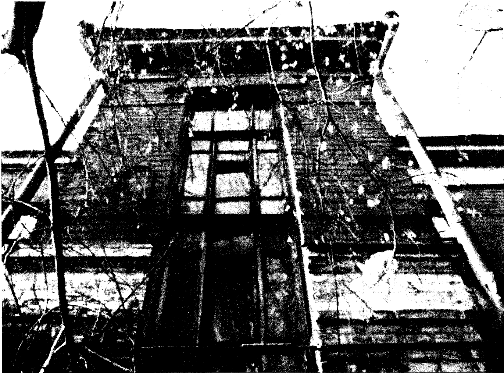
Фото 9 - Фрагмент юго-восточного фасада
