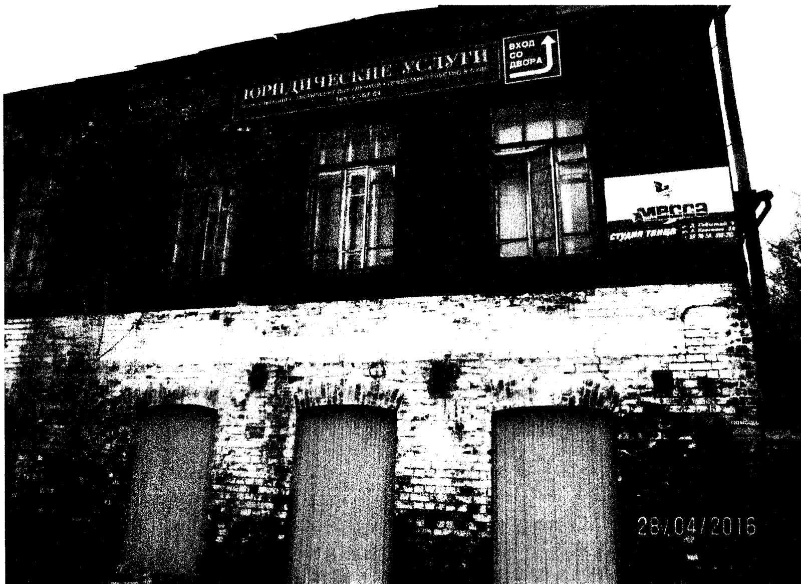
Фото 12 - Оконные проемы юго-западного фасада
