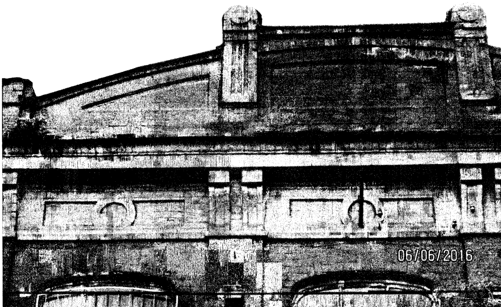
Фото 5 - Аттиковая стенка на главном фасаде
