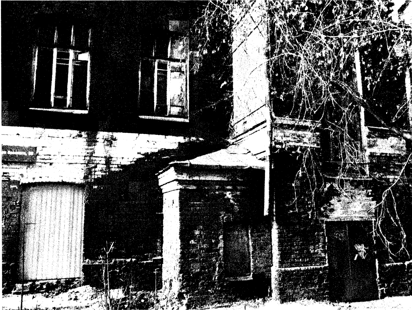
Фото 10 - Фрагмент юго-восточного фасада
