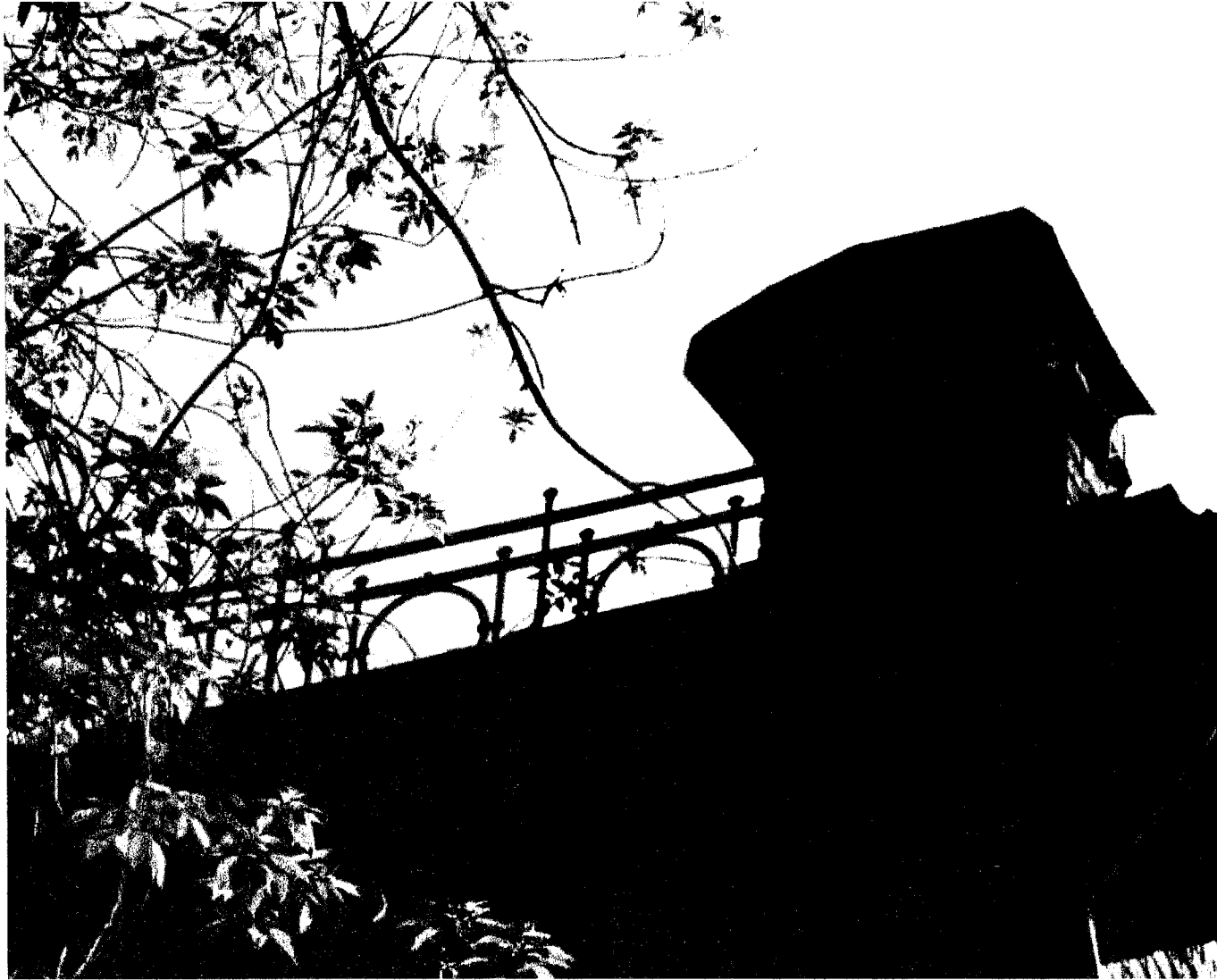
Фото 6 - Ограждение кровли. Главный фасад
