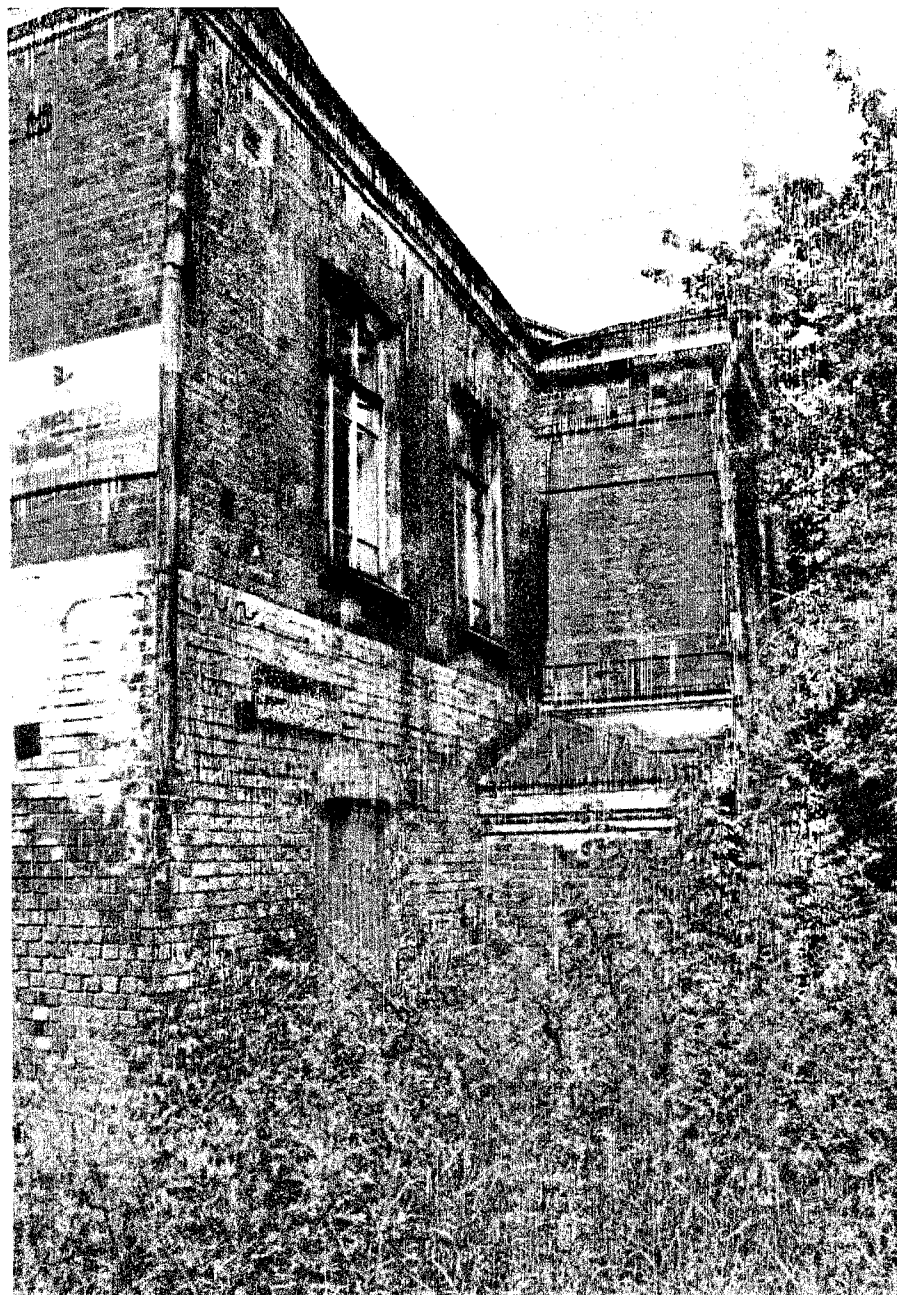
Фото 8 - Фрагмент юго-восточного фасада
