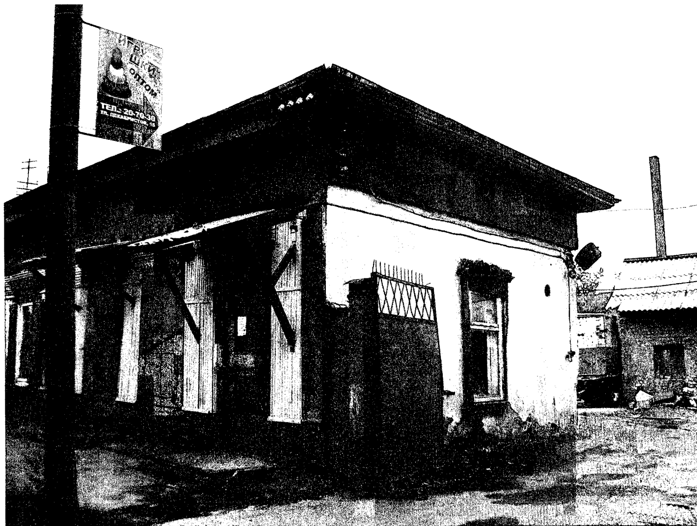
Архивное фото 4 - Фрагмент юго-восточного фасада объекта. Вид с востока, с улицы Декабристов
