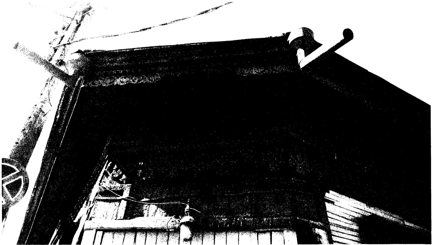
Фото 4 - Срезанный угол объекта культурного наследия. Декоративные элементы оформления – угловые лопатки, декорированный фриз и подшивной профилированный карниз
