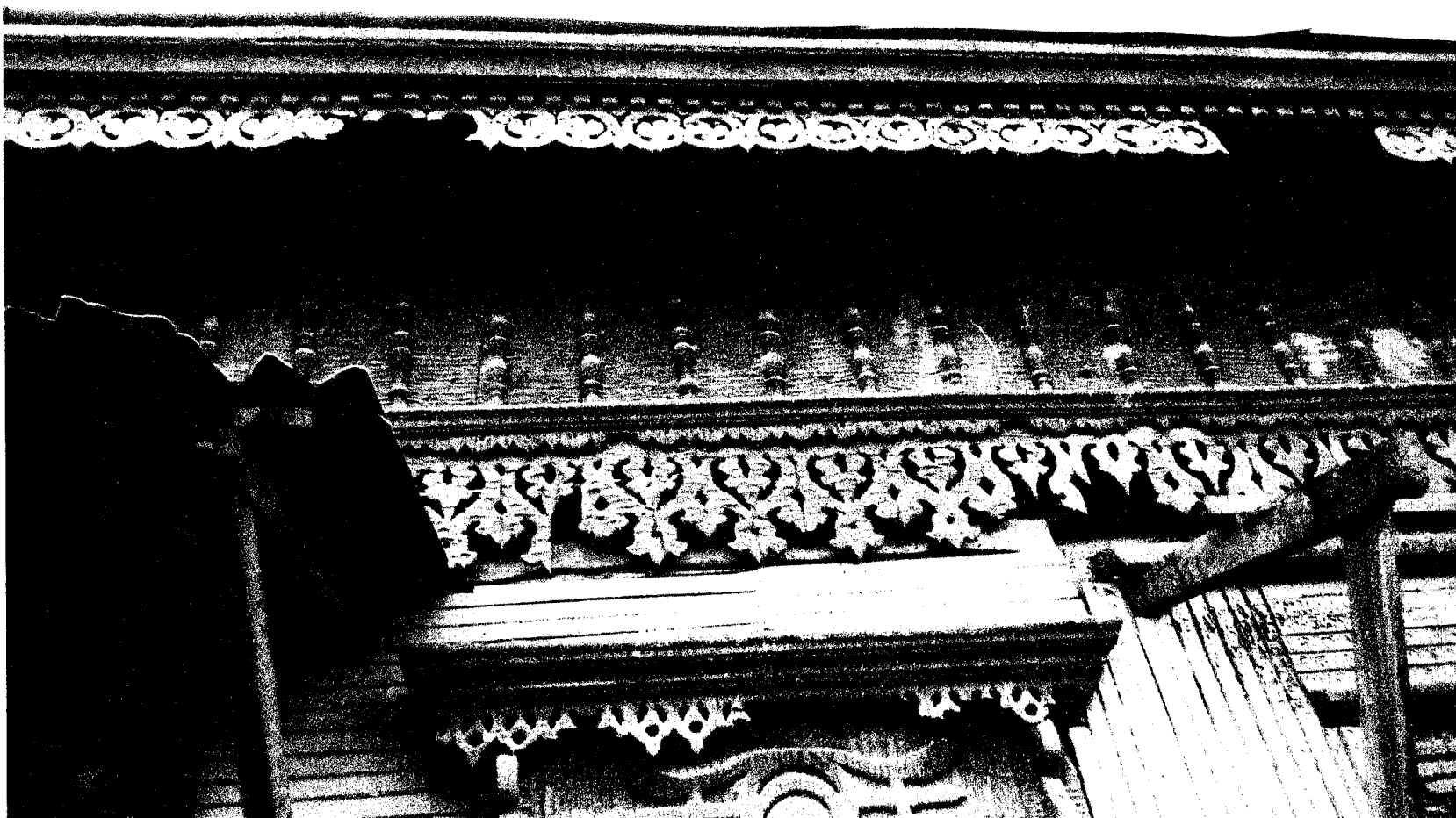
Фото 5 - Фрагмент юго-восточного фасада объекта культурного наследия по улице Декабристов. Декоративные элементы оформления фасада
