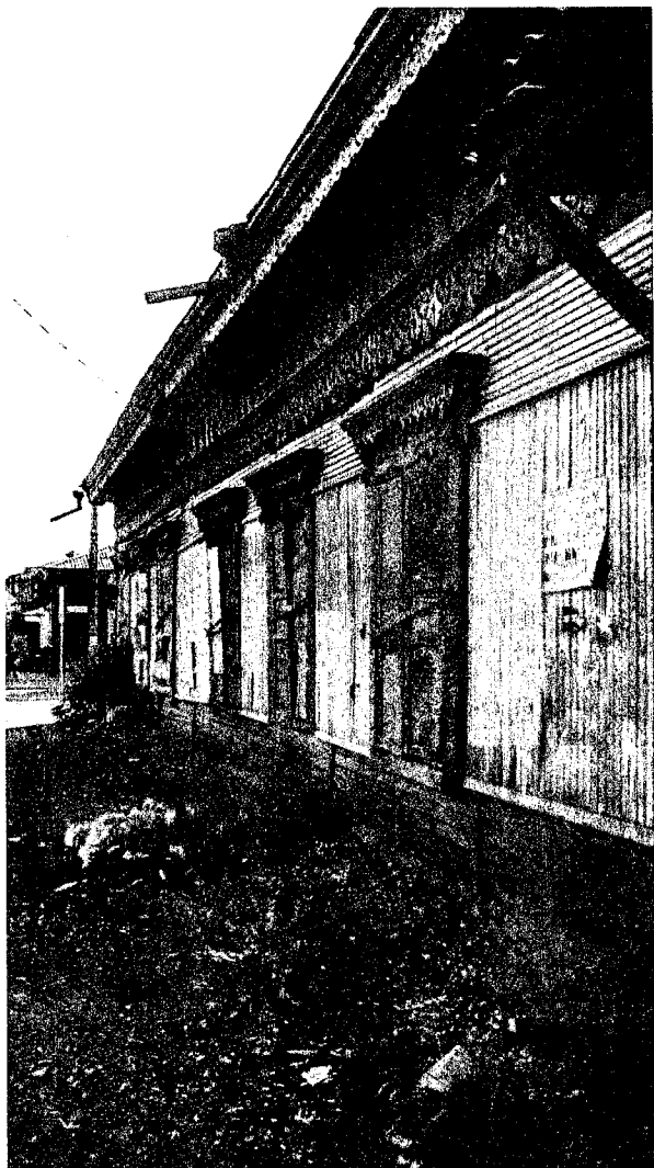
Фото 2 - Фрагмент юго-восточного фасада
