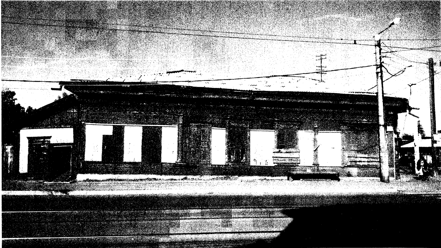
Фото 1 - Юго-западный фасад объекта культурного наследия. Вид с улицы Ремесленная
