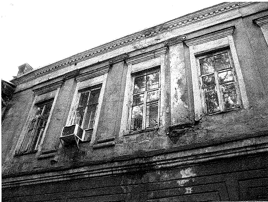
17. Юго-западный фасад. Объем № 2. Ложный ризалит, второй этаж.
