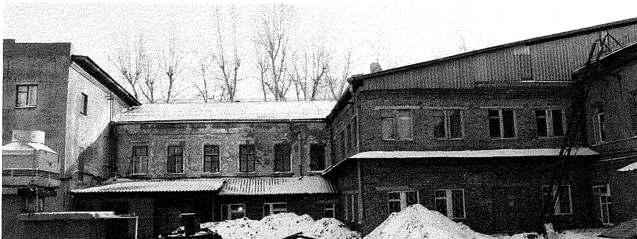
Фото А.А. Жильцов, ноябрь 2018 г. Вид на открытую часть дворового северо-западного фасада. Объем № 1.
