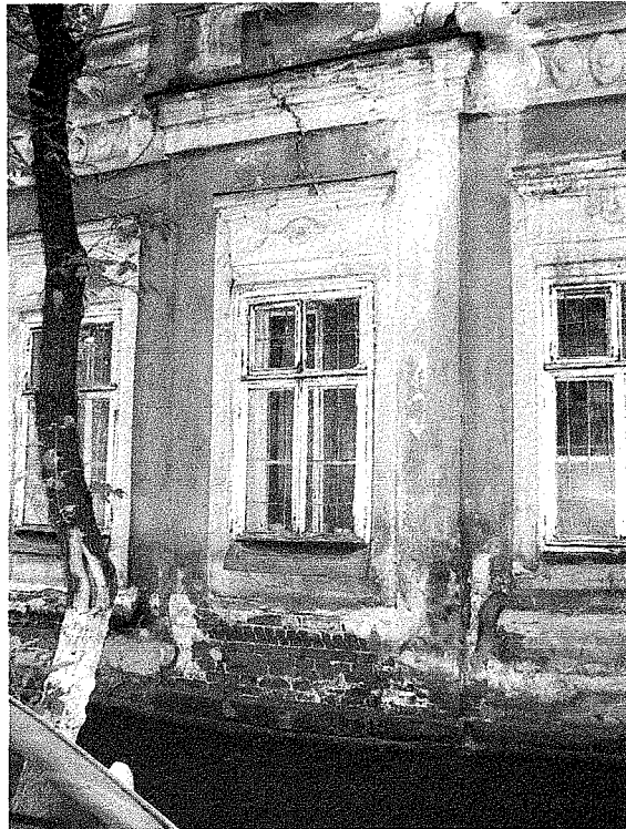
8. Юго-восточный фасад. Объем №2. Ложный ризалит первого этажа по центральной (6-ой) оси.
