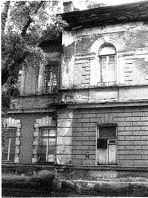
29. Юго-западный фасад. Фрагмент (по 9-10-й осям)
