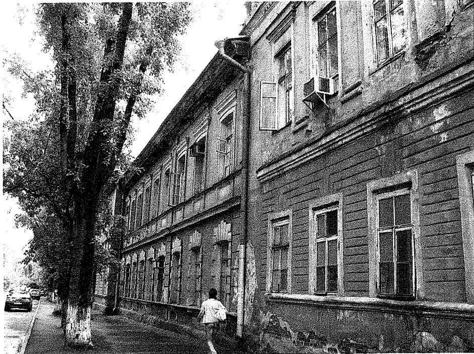
12. Юго-западный фасад. Общий вид.
