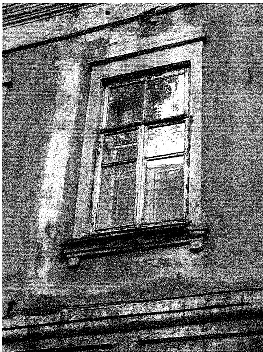
4. Юго-восточный фасад. Объем №1. Наличник второго этажа.
