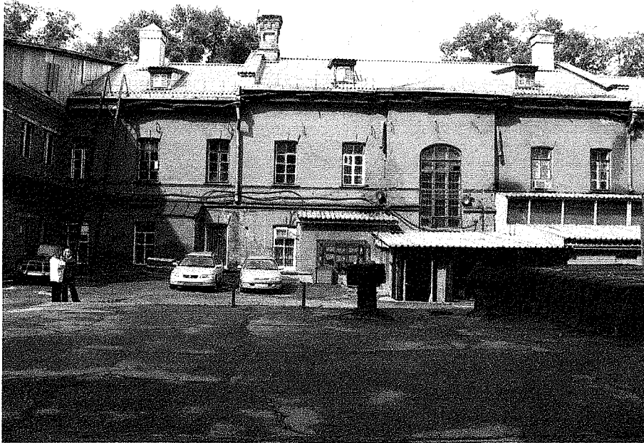
37. Дворовый северо-восточный фасад. Объем № 3. Фрагмент (по 1-8-й осям)
