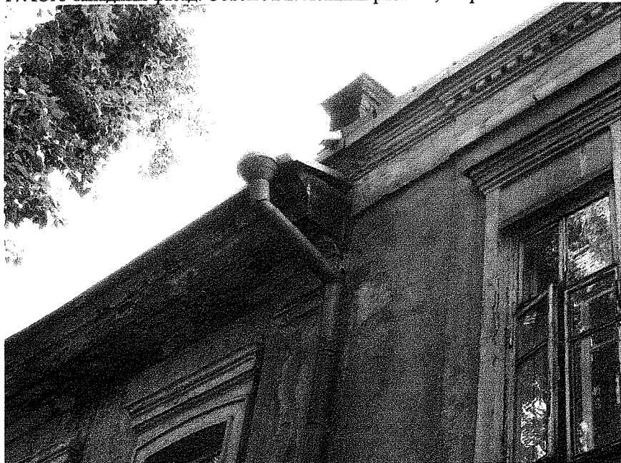
18. Юго-западный фасад. Фрагмент примыкания объема № 2 и объема № 3.
