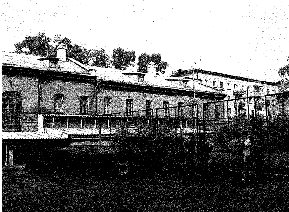
38. Дворовый северо-восточный фасад. Объем № 3. Фрагмент (по 6-16-й осям)
