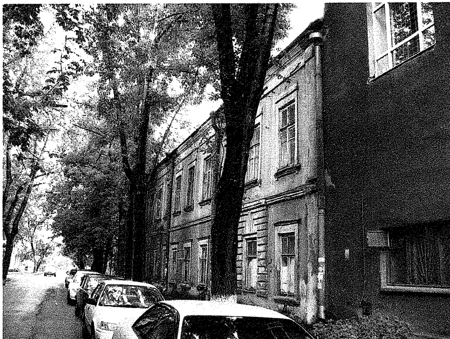
1. Юго-восточный фасад. Общий вид. Объем №1.
