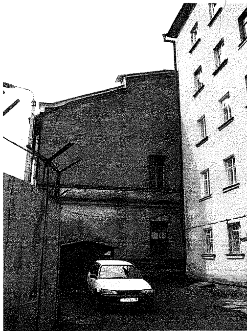
34. Торцевой северо-западный фасад. Фрагмент.
