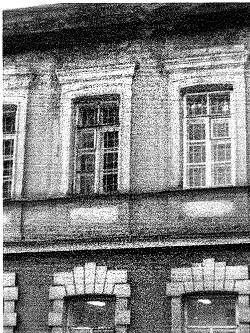
26. Юго-западный фасад. Объем № 3. Фрагмент (по 5-6-й осям)
