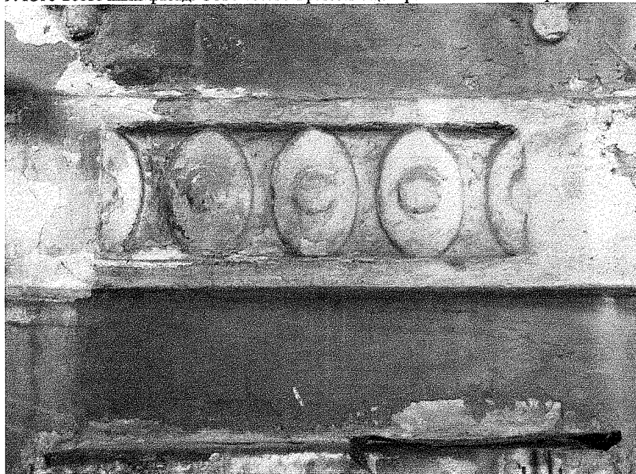
10. Юго-восточный фасад. Объем № 2. Фрагмент. Декоративный элемент межэтажного пояса (центрального ризалита).
