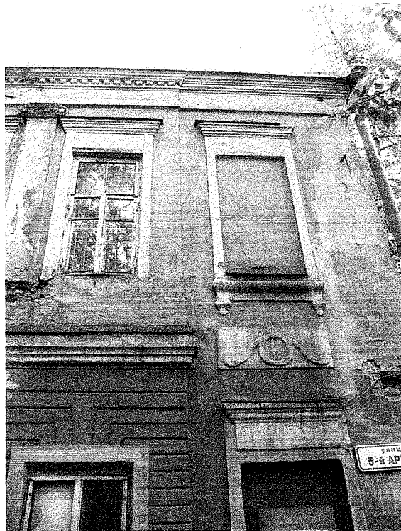
16. Юго-западный фасад. Объем № 2. Угловой фрагмент с заложенными проемами (по 5-ой оси).
