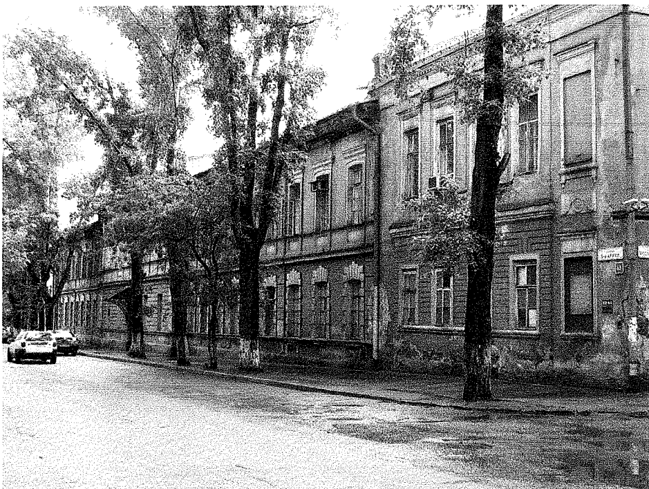
22. Юго-западный фасад. Фрагмент.
