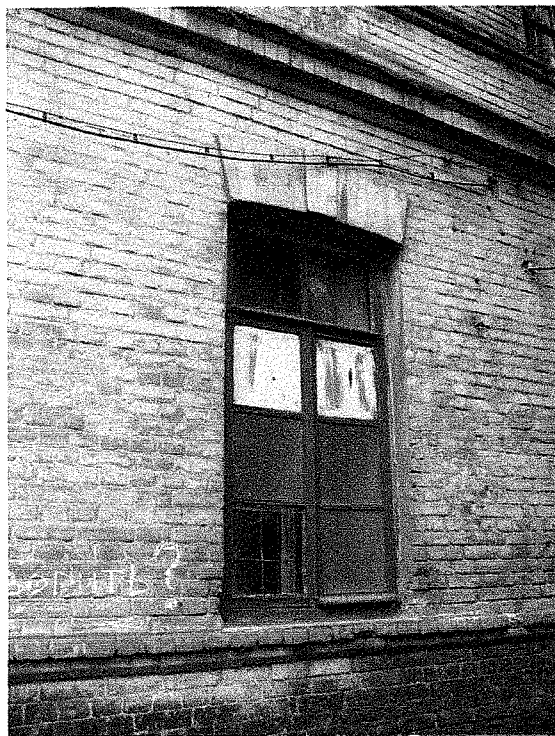
32. Торцевой (северо-западный) фасад. Фрагмент.
