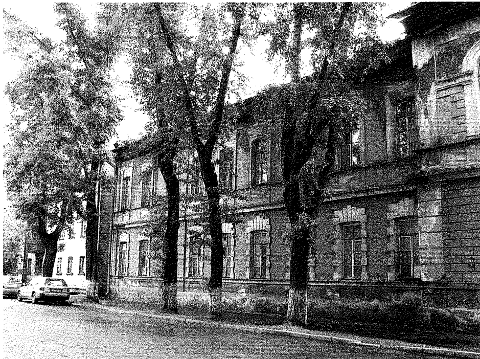
28. Юго-западный фасад. Объем № 3. Фрагмент по 1-9-й осям.
