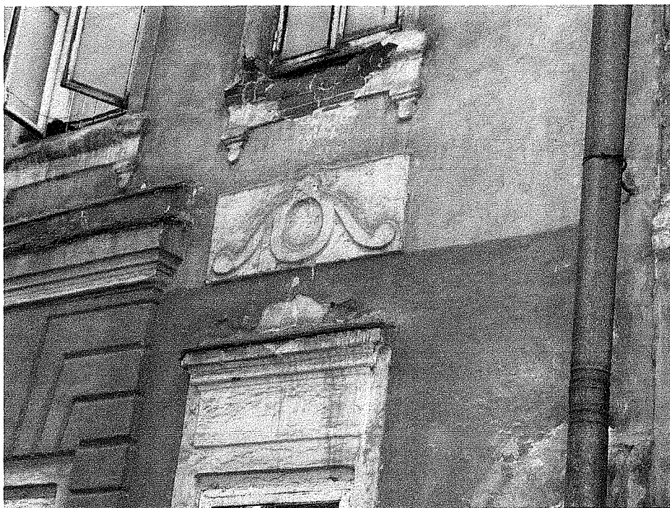
6. Юго-восточный фасад. Объем № 2. Фрагмент. Декоративный элемент межэтажного пояса.
