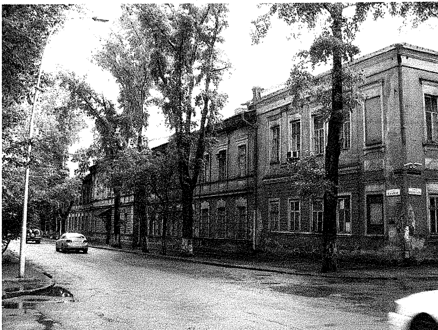
21. Юго-западный фасад. Общий вид (объемы 3-2)
