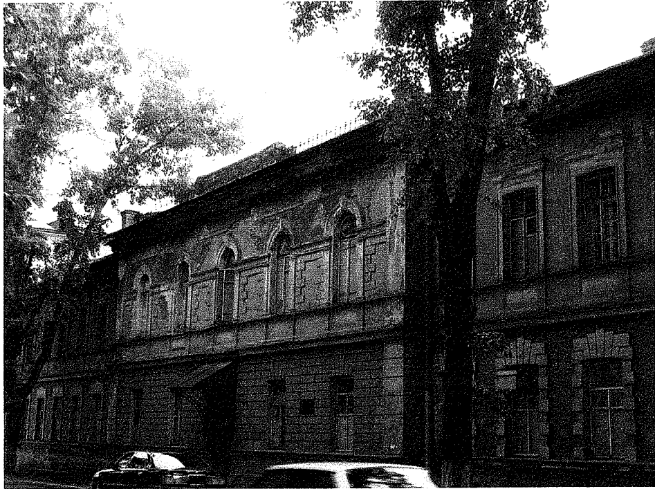
23. Юго-западный фасад. Объем № 3. Центральный ризалит.
