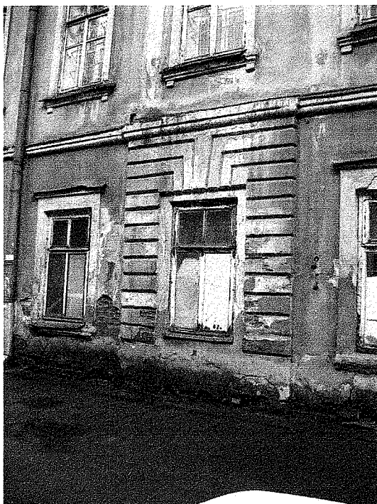
2. Юго-восточный фасад. Объем №1. Фрагмент ложного ризалита в уровне первого этажа
