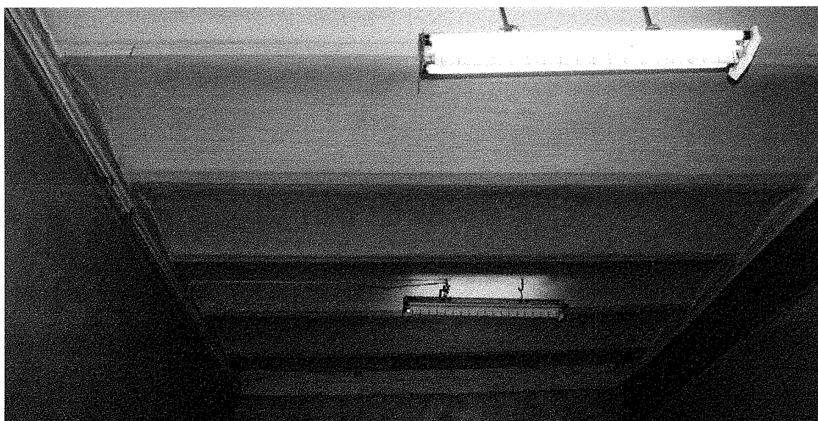
Фото А.А. Жильцов, ноябрь 2018 г. Оштукатуренные кирпичные сводики по металлическим двутавровым балкам в пом. № 12 (по плану Иркутского филиала ФГУП «Ростехинвентаризация») на 1 этаже. Объем № 3.
