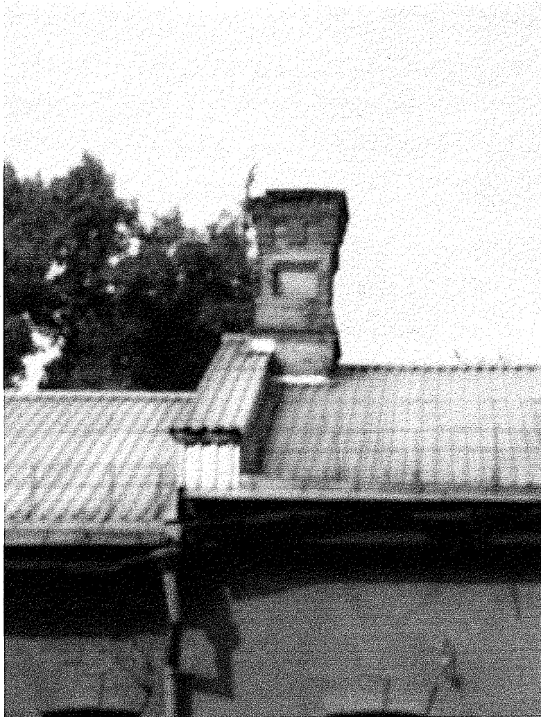
39. Дворовой фасад. Объем № 3. Воздухоотвод.
