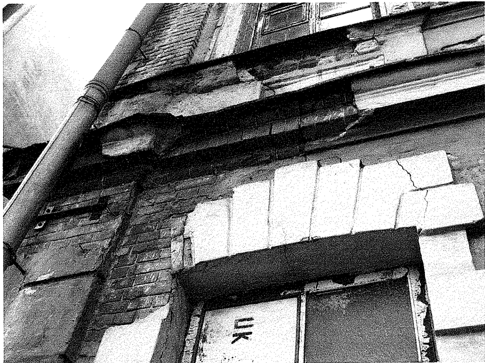
30. Юго-западный фасад. Фрагмент (по 1-й оси)
