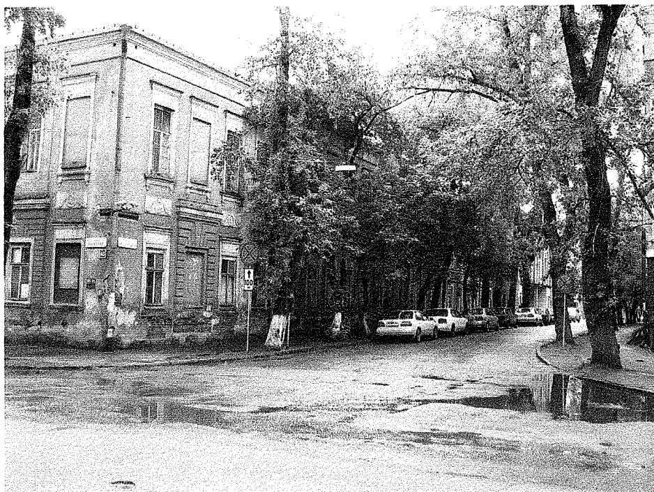
14. Юго-восточный фасад. Общий вид. На переднем плане угловой объем (№2)
