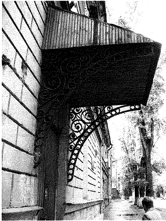
35. Юго-западный фасад. Козырек.
