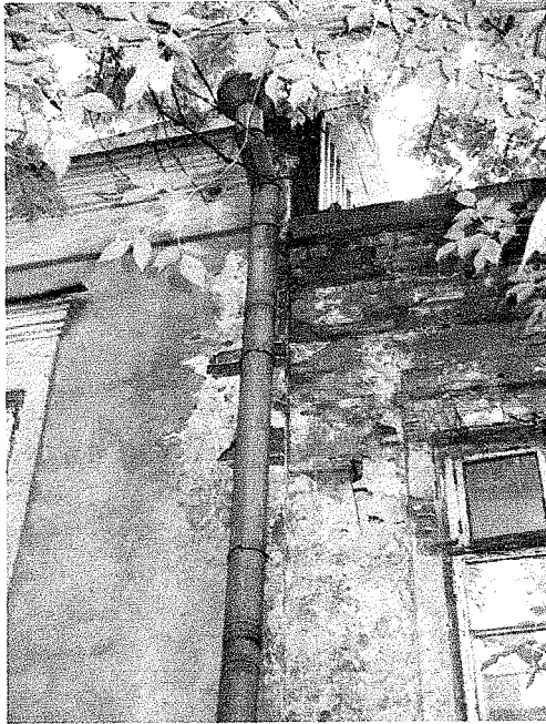
7. Юго-восточный фасад. Фрагмент. Место примыкания объема №1 к объему №2.
