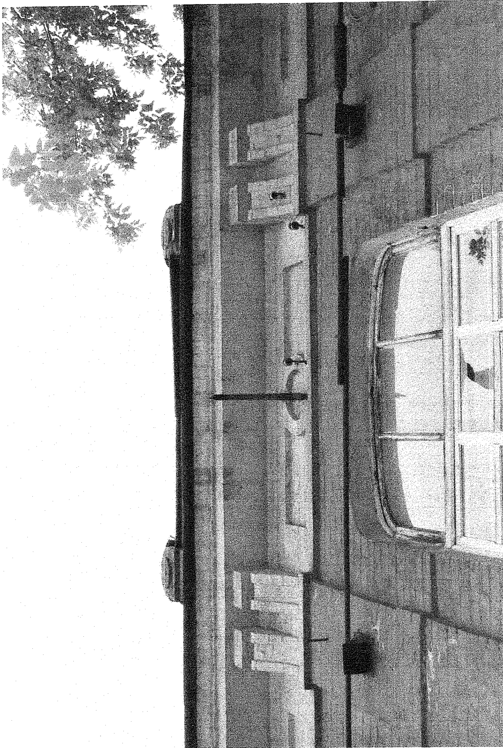
Фото 3 - Фриз и карниз на главном фасаде
