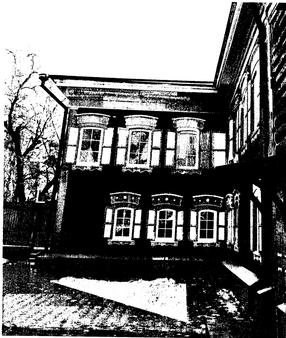
Фото 6 - Прируб северо-восточного фасада
