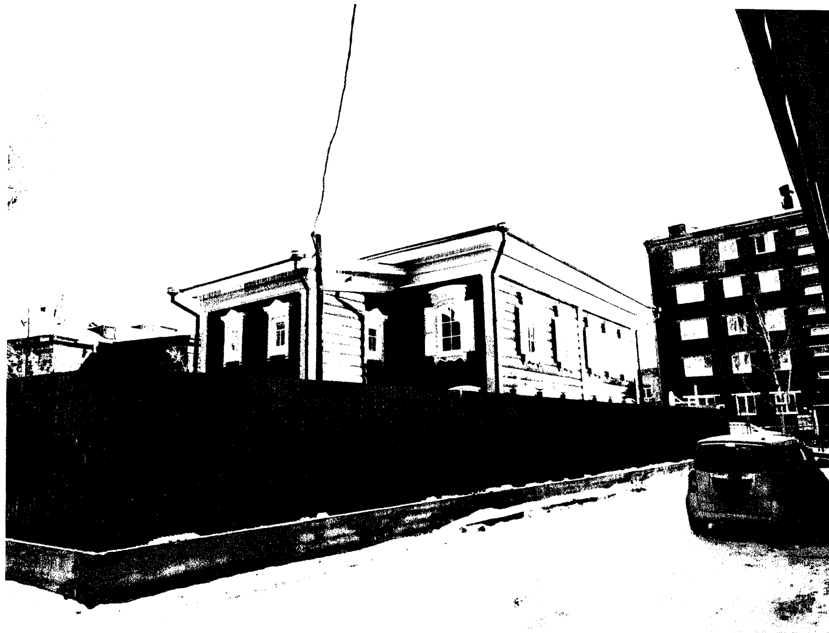
Фото 2 - Северо-западный фасад, фрагмент юго-западного фасада
