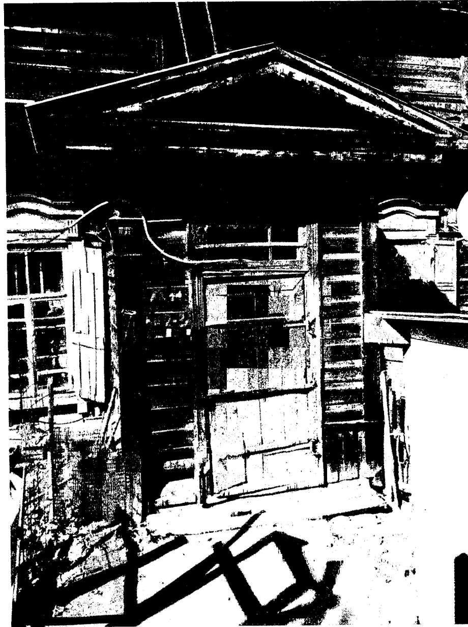
Фото 5 - Пристрой сенией со стороны юго-западного фасада, расположенный в южном углу жилого дома
