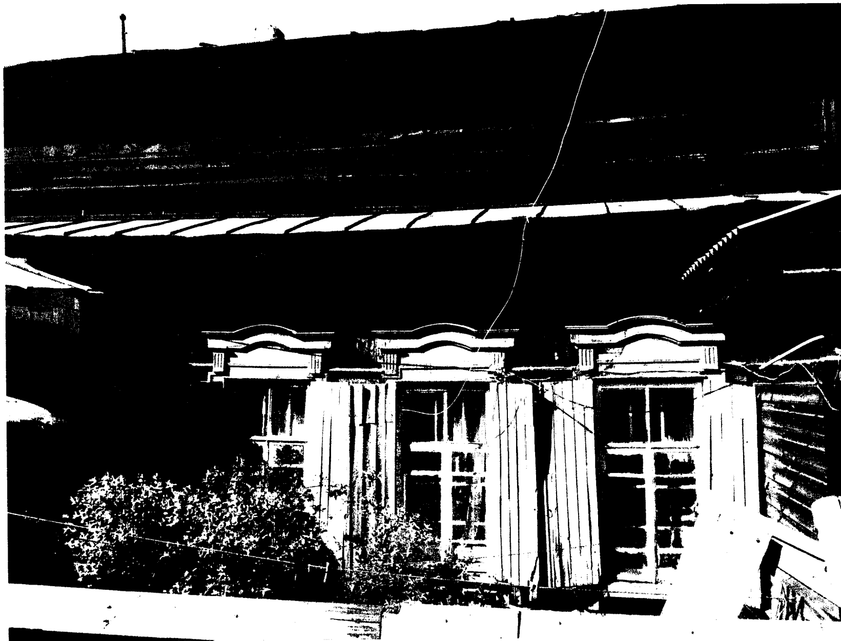
Фото 2 - Три центральных оконных проема со стороны юго-западного фасада
