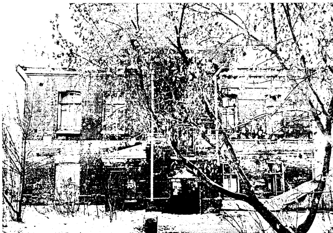
2. Вид на юго-восточный фасад здания
