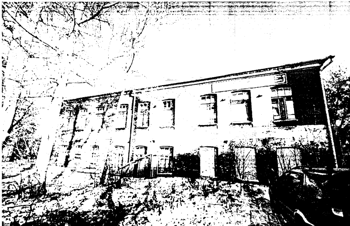
3. Вид на юго-западный фасад здания
