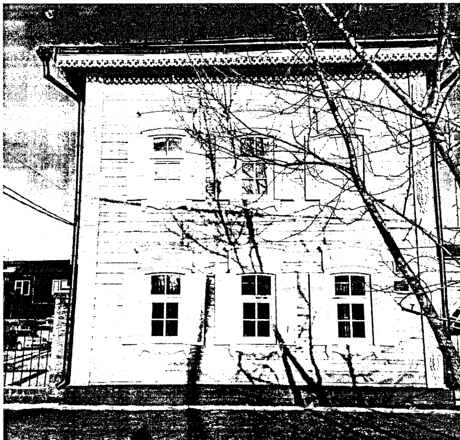
Фото 1 – Главный (юго-западный) фасад
