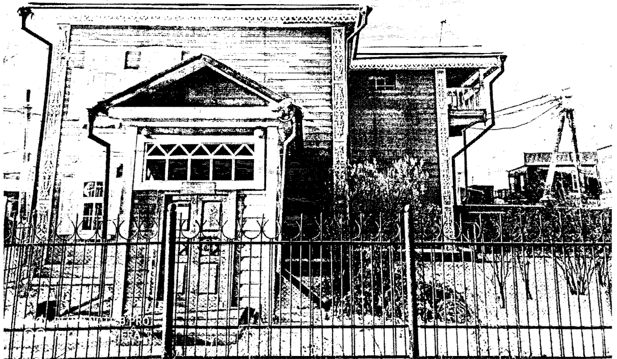
Фото 3 – Юго-восточный фасад (боковой)
