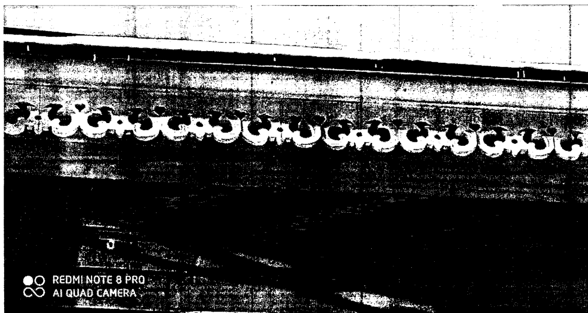
Фото 2 – Юго-западный фасад (главный). Карниз
