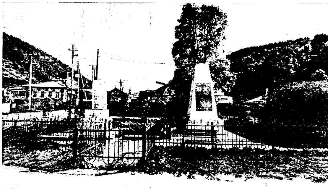
Фото 3 – Общий вид на Объект с юго-запада
