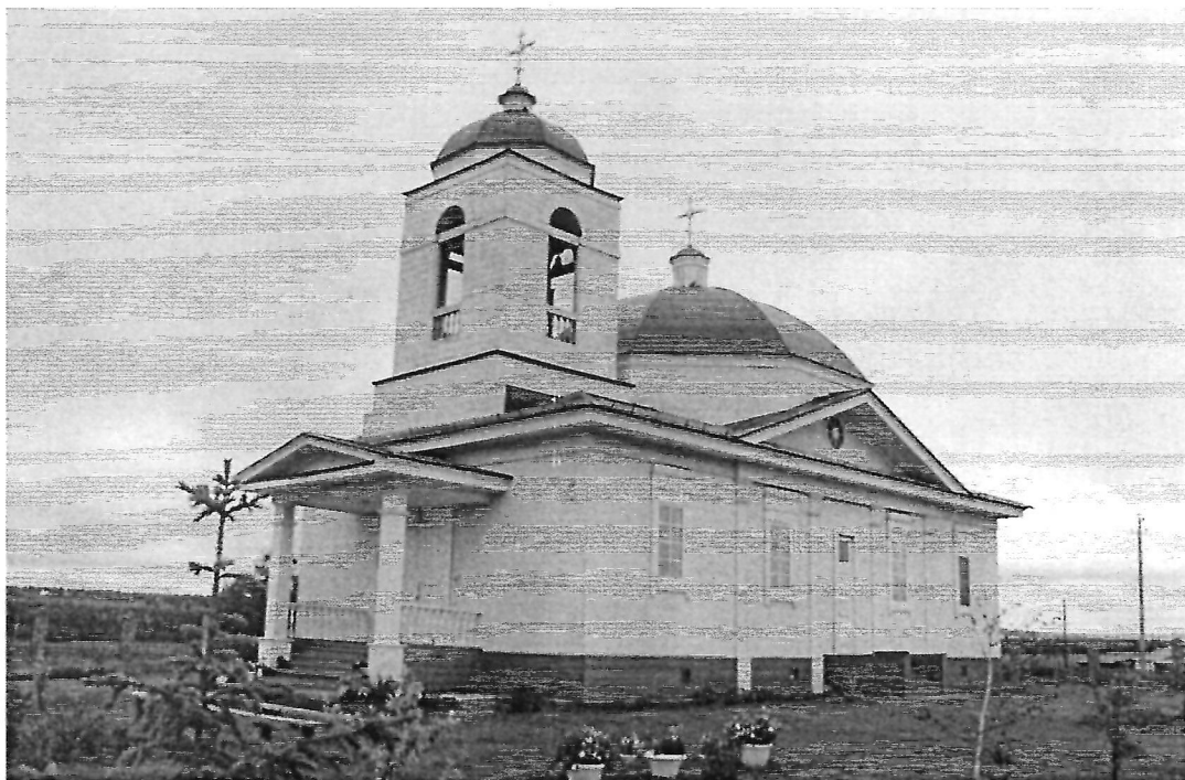
Фото 1 – Общий вид на северный и восточный фасады. Одноэтажный объем храма с восьмигранным объемом и трехчастной колокольней над ним
