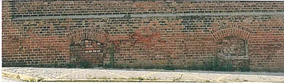
Фото 17. Вид оконных проемов на восточном фасаде.
