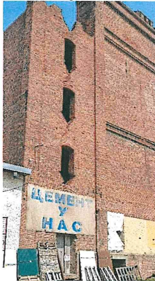
Фото 18. Вид оконных и дверных проемов на южном фасаде.
