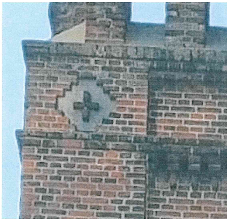
Фото 26. Верхние части лопаток фасадов.
