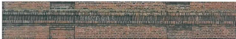
Фото 25. Межэтажный карниз на фасадах.
