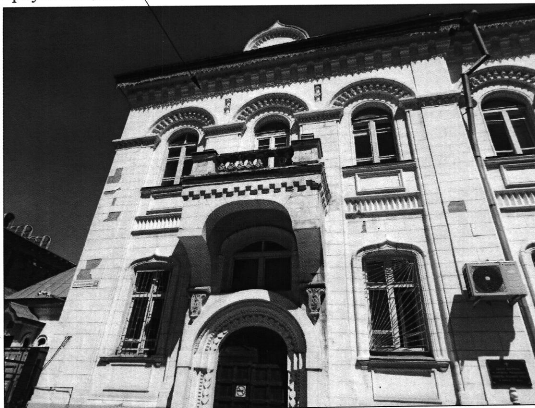
Венчающий карниз корпуса общины
