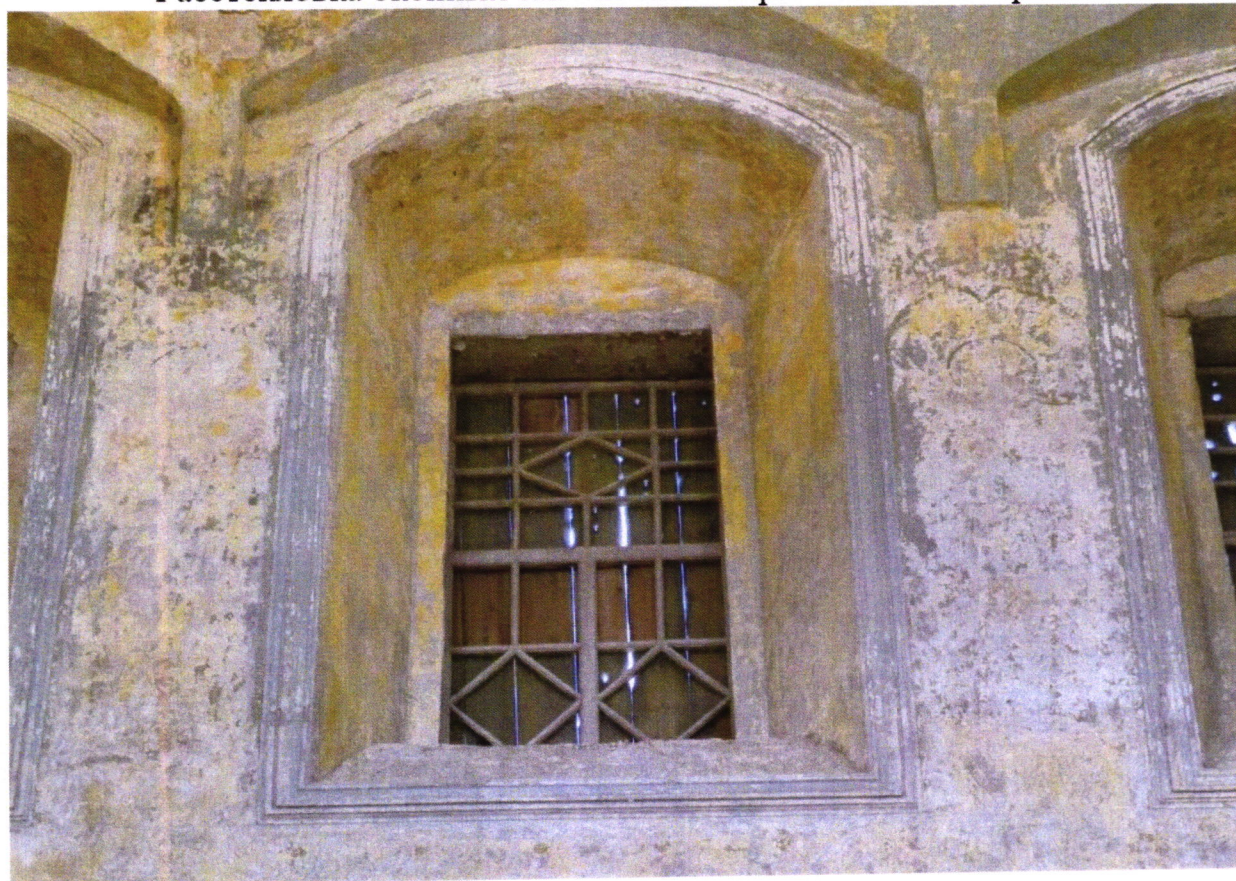
Расстекловка оконных заполнений второго света четверика.
