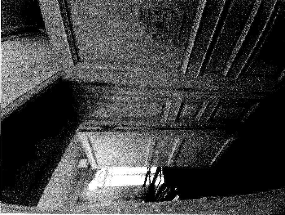
Филеичатые двери, отделка дверных откосов деревянными в филеичатыми панелями
