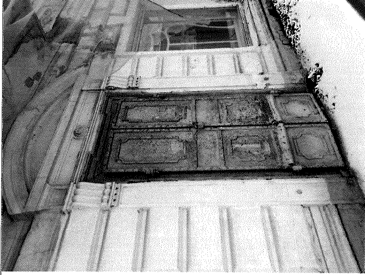
Входная дверь с западной стороны южного корпуса
