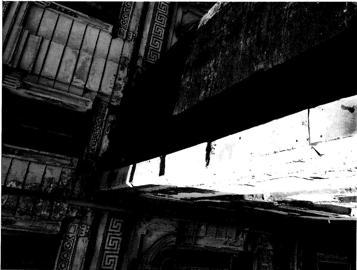
Вид сверху на кровлю перехода между главным и южным корпусами
