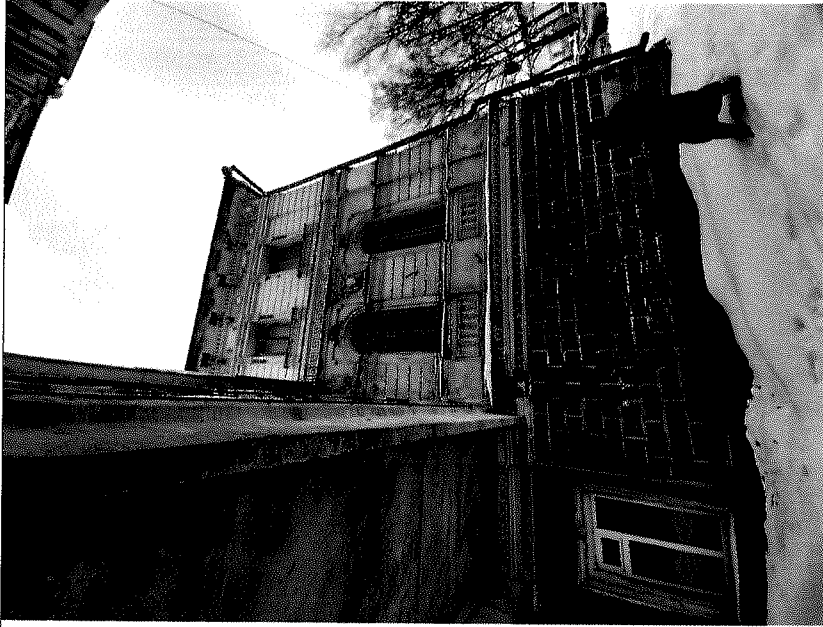
Южный фасад главного корпуса по правую сторону от перехода в южный корпус
