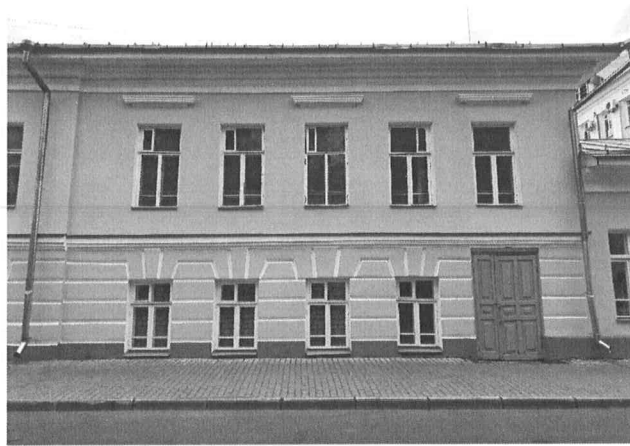
Фотография 14 – Прямоугольное очертание оконных проемов первого и второго этажей
