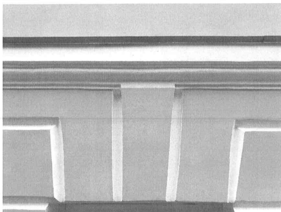
Фотография 8 – Клинчатые замковые камни над оконными проемами первого этажа главного (северного) фасада
