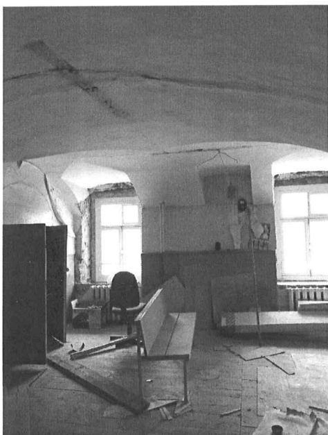
Фотография 20, 21 – Сводчатые перекрытия в помещениях первого этажа
