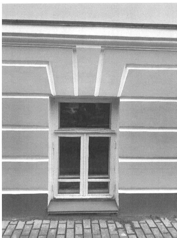
Фотография 7 – Клинчатые замковые камни над оконными проемами первого этажа главного (северного) фасада
