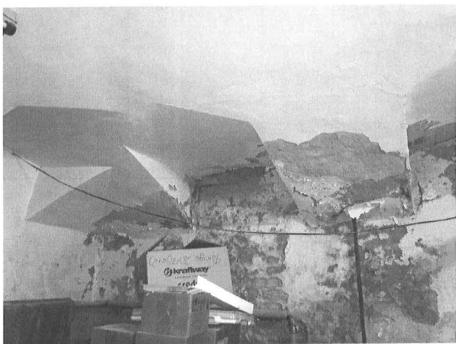
Фотография 22 – Распалубки над окнами в помещениях первого этажа
