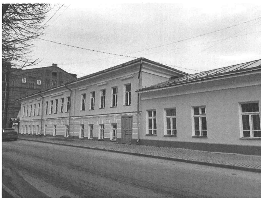
Фотография 2 – Северный фасад здания
