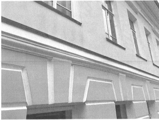
Фотография 11 – Междуэтажный профилированный карниз главного (северного) фасада
