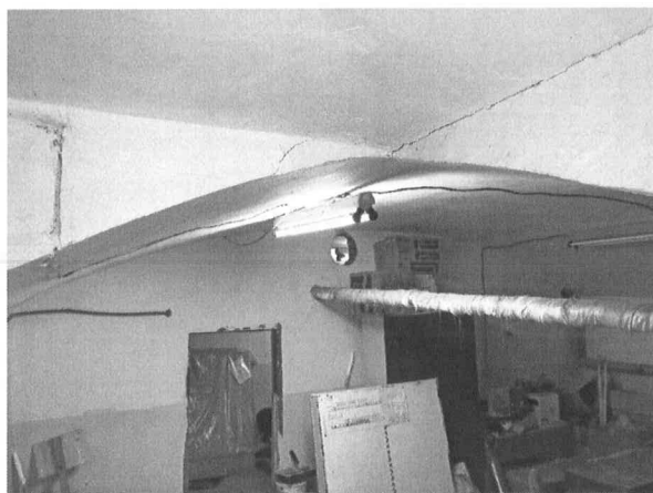
Фотография 19 – Сводчатые перекрытия в помещениях первого этажа
