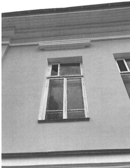
Фотография 12 – Венчающий профилированный карниз главного (северного) фасада
