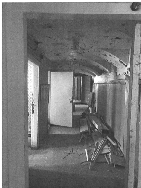
Фотография 20, 21 – Сводчатые перекрытия в помещениях первого этажа
