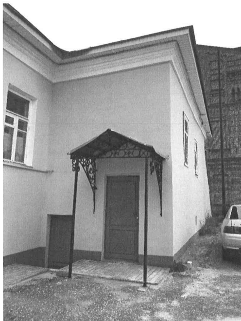
Фотография 13 – Венчающий профилированный карниз южного фасада
