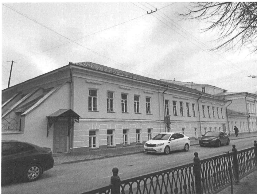
Фотография 1 – Северный фасад здания
