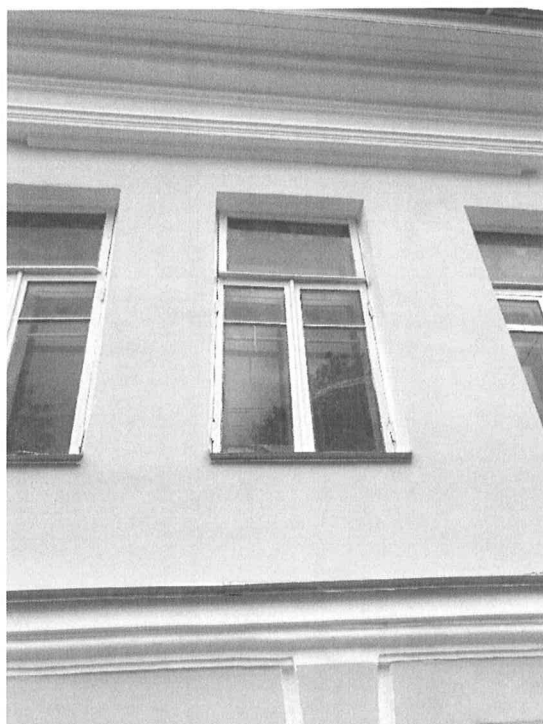
Фотография 9 – Профилированные сандрики-полочки над оконными проемами второго этажа со стороны главного (северного) фасада
