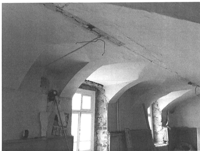
Фотография 23 – Распалубки над окнами в помещениях первого этажа
