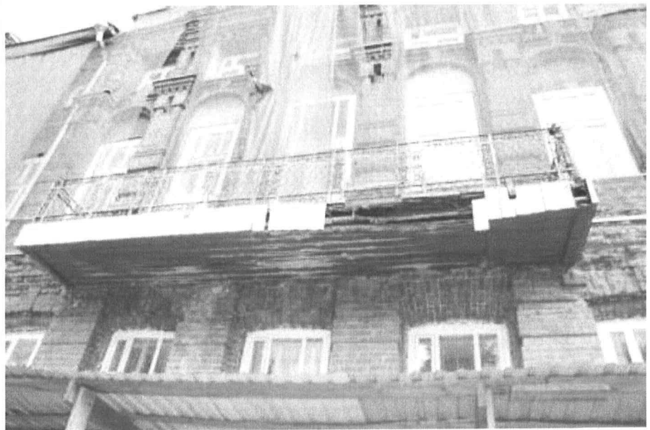
Кованое ограждение балкона
