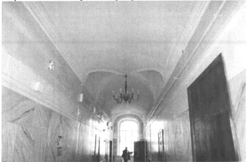
Тянутый потолочные карниз в коридоре 2-го этажа
