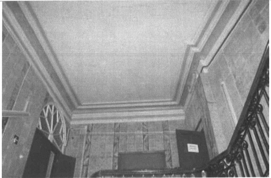
Профиль тянутого карниза парадной лестницы
