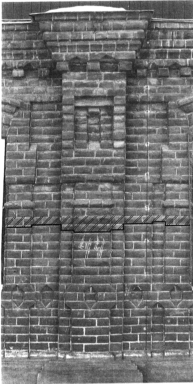
Сечение1. Рельефный декор из кирпича. М 1:20.
