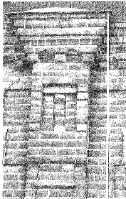
Деталь 1. Рельефный декор из кирпича со стороны северо-восточного фасада. М 1:20.
