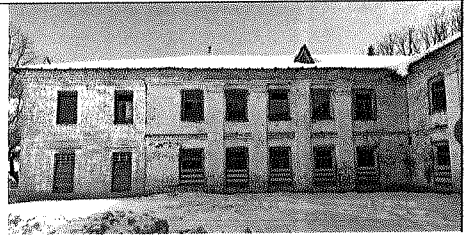
Вид на северо-западный внутренний фасад (со стороны храма)
