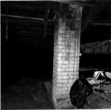
Дымоходы в уровне кровли.
