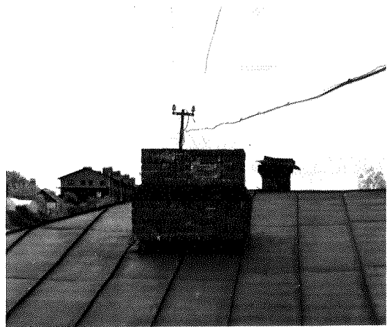
Дымоходы в уровне кровли.
