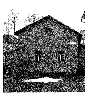
Общий вид с юго-запада. Южный объем.
