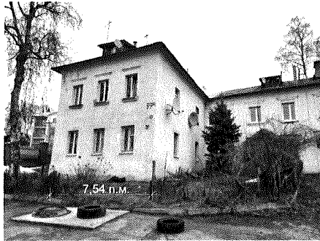
Северный объем. Общий вид с юга
