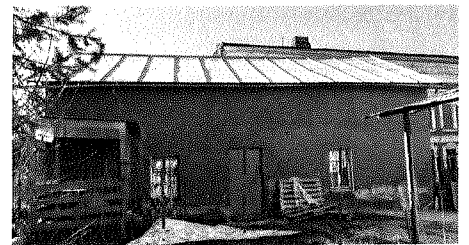
Южный объем. Северо-западный фасад
