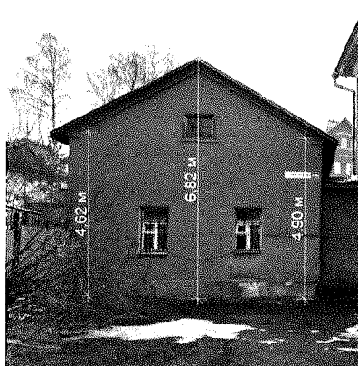
Южный объем. Юго-западный фасад
