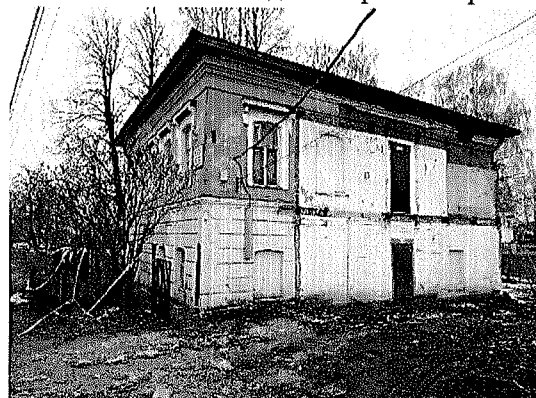
Фото №2. Вид с северной стороны
