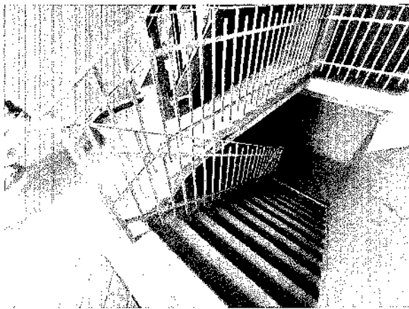
Ограждение черновой лестницы
