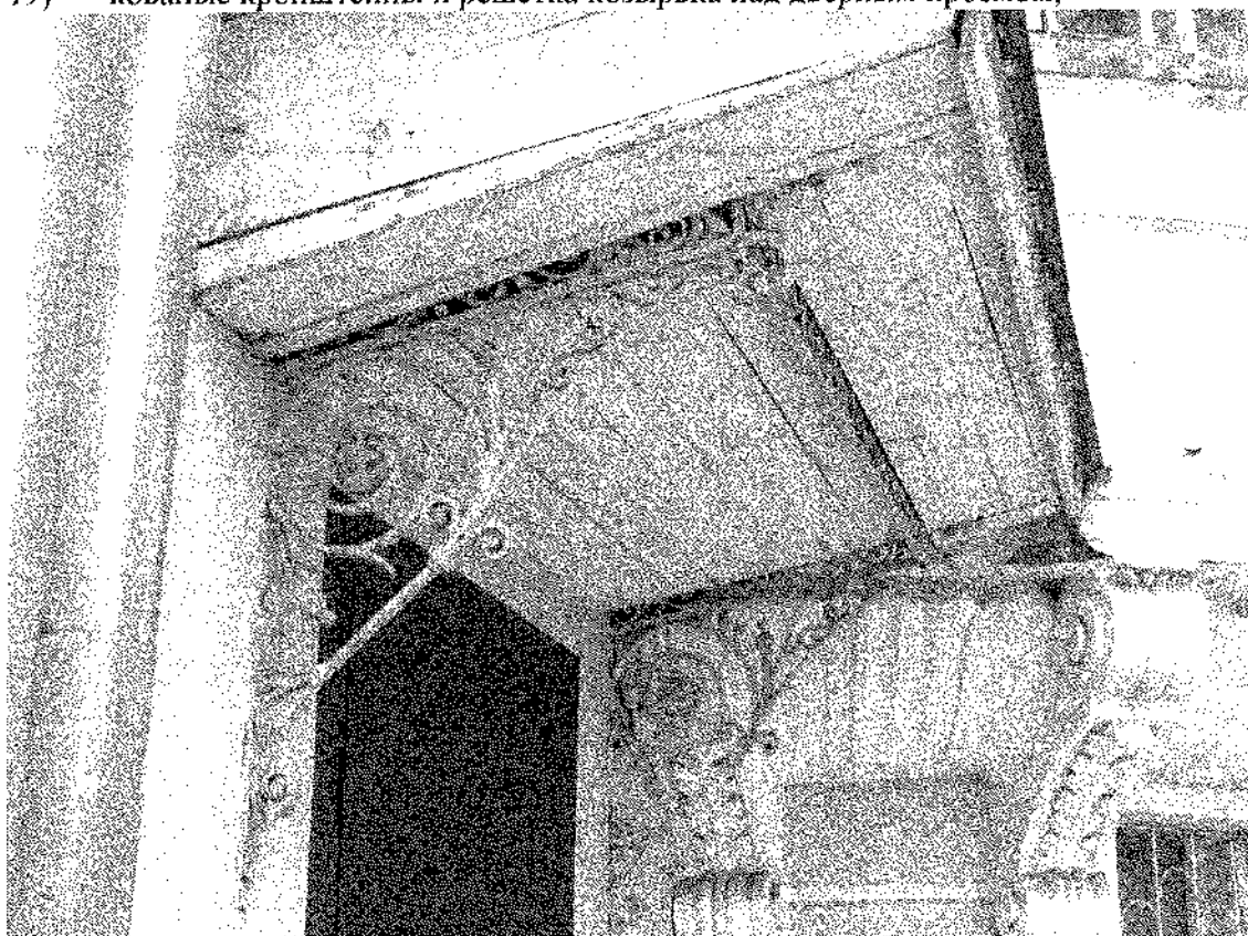
20) фрагмент накладной доски по правому флангу арочного проема основного объема здания в уровне второго этажа.
