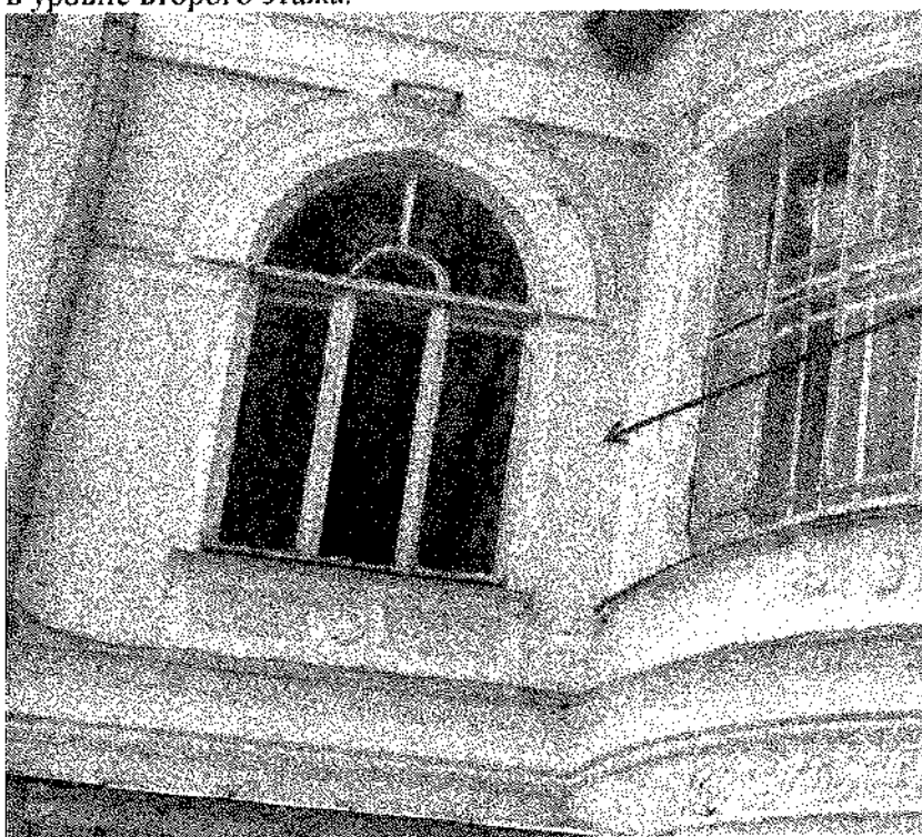
20) фрагмент накладной доски по правому флангу арочного проема основного объема здания в уровне второго этажа.
