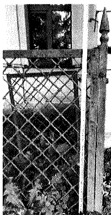
Главный фасад. Металлическое ограждение с капиткой на металлических столбиках
