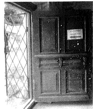
заполнение входного проема
