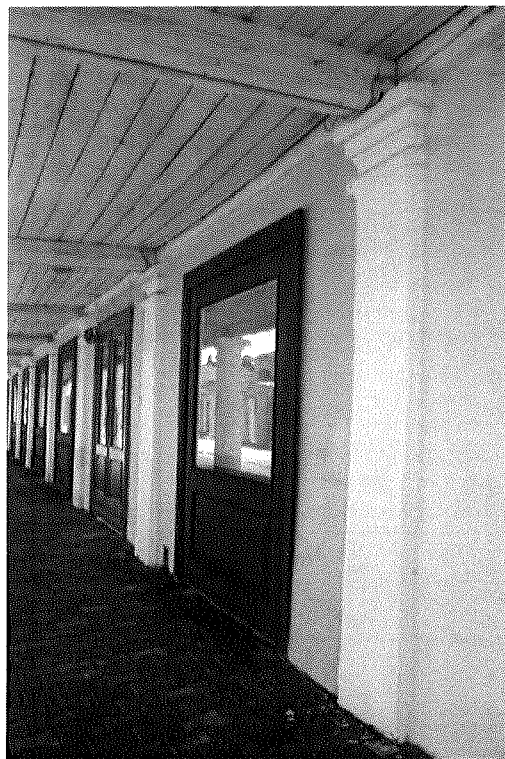
Галерея юго-восточного фасада. Фото 22.03.2023 г.
