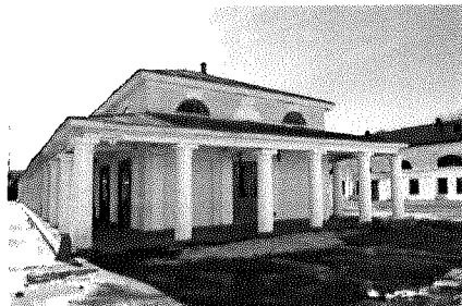
Общий вид с северо-востока
