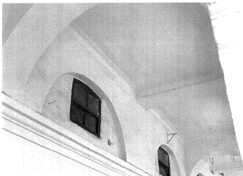
Фотофиксация. Потолочная падуга галереи северо-западного фасада.
