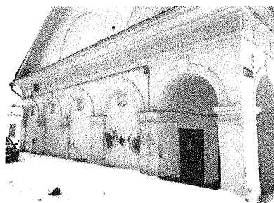
Фрагмент северо-восточного фасада.
