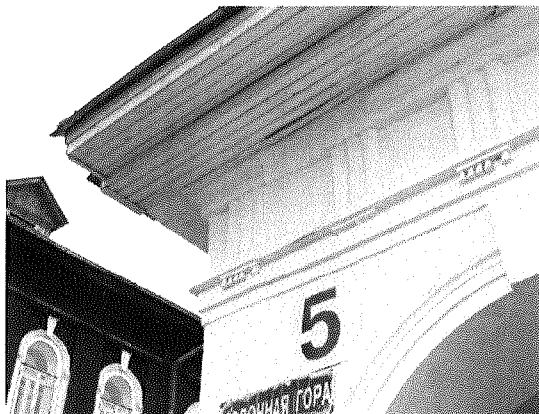
Фотофиксация. Венчающий карниз.
