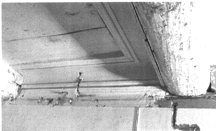
Фотофиксация. Потолочная падуга 2-го этажа.
