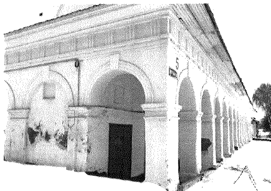
Фотофиксация. Венчающий карниз.
