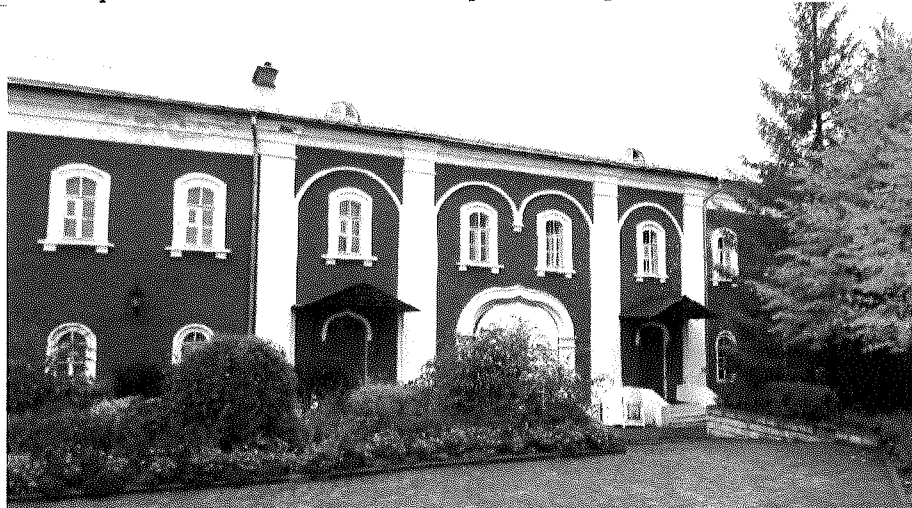
Восточная часть здания – свечной корпус, 2-я пол. XIX в.
