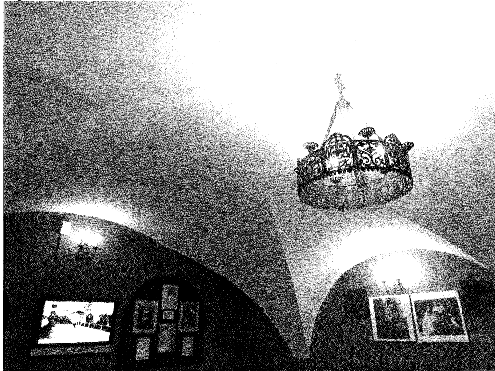
- западный объем (кладовая) - кирпичные коробовые своды с распалубками в перекрытии первого этажа;
