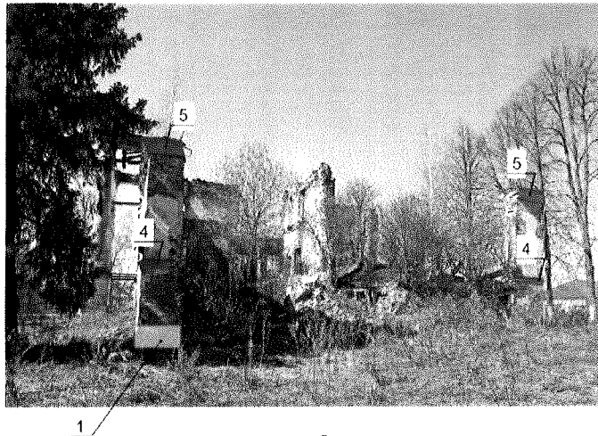
Восточный фасад (историческая фотофиксация)
